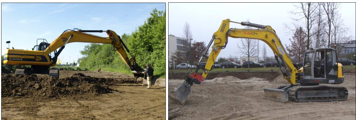
Abb. 6 Links: Kettenbagger beim Oberbodenabtrag. Rechts: Yanmar-Minibagger.
