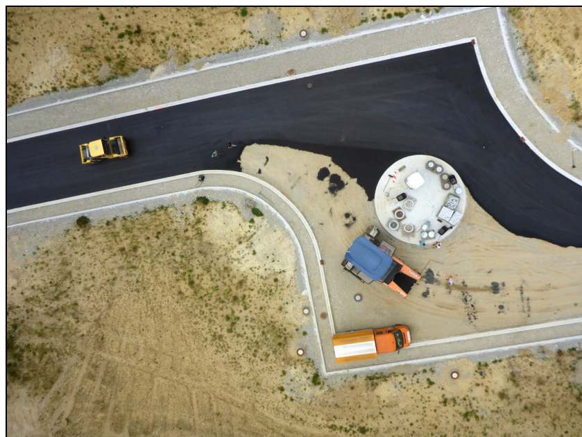
Abb. 6 Die Erschließungsstraßen werden geteert (Luftbild mit dem Hebedrachen).
