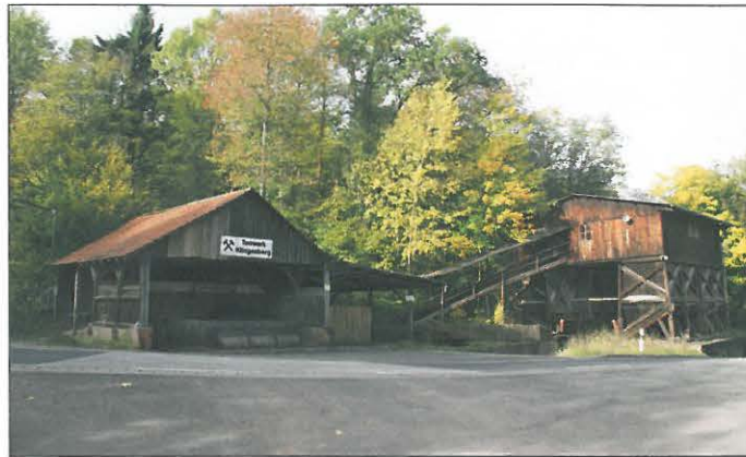
19 Lagerbox, Kettenstegförderer und Bunkeranlage Foto: E. Ehrh
