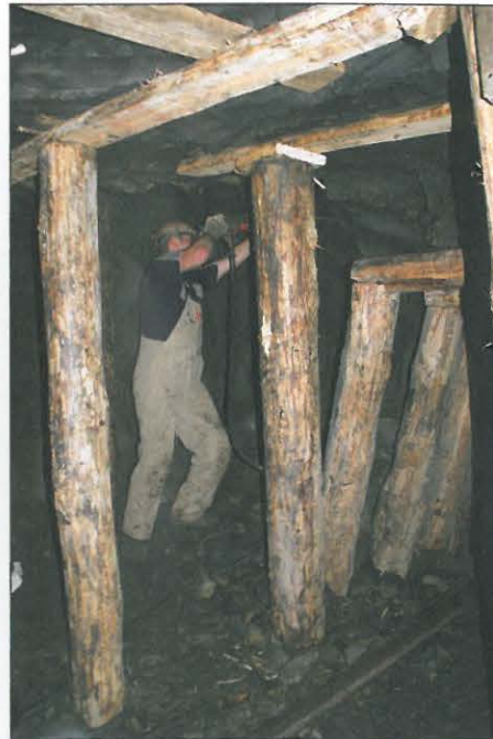
17 Abbaustrecke, die zu einer Kammer erweitert wird (2. Phase)
