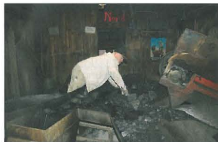
20 Abwurf des Kettenstegförderers auf den Sortiertisch Foto: E. Ehrh
