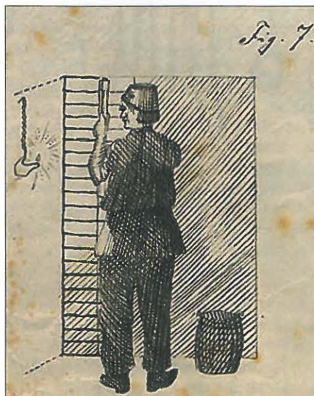
7 Hauer beim Schlitzten der Ortsbrust und verwendetes Gezähe Dr. Hohn 1876
