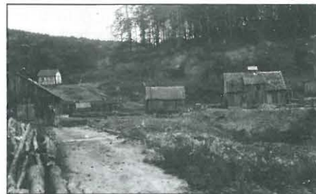
9 Betriebsgelände mit Schachtkauen Anfang des 20. Jahrhunderts; Blick von Süden nach Norden Foto: Archiv Stadt Klingenberg am Main
