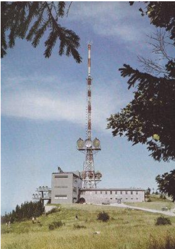
Erweiterungsbau bei Richtfunkstation
