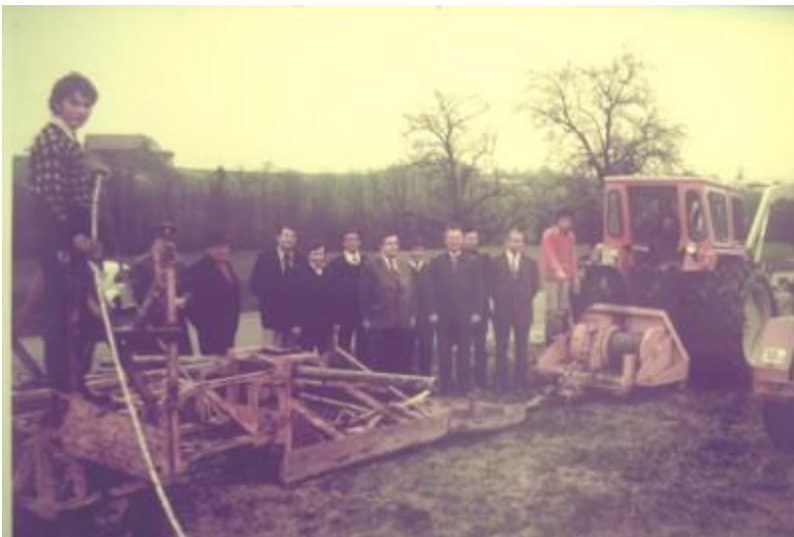
Erster Einsatz eines Kabelpfluges im
