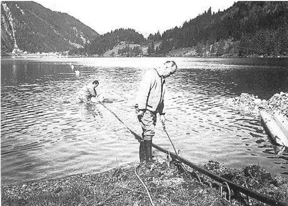
Erste Seekabellegung mit
