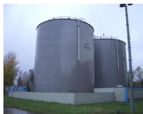
Abb. 41 Heizöl-Tank Quelle: Michael Prytula, TU Berlin
