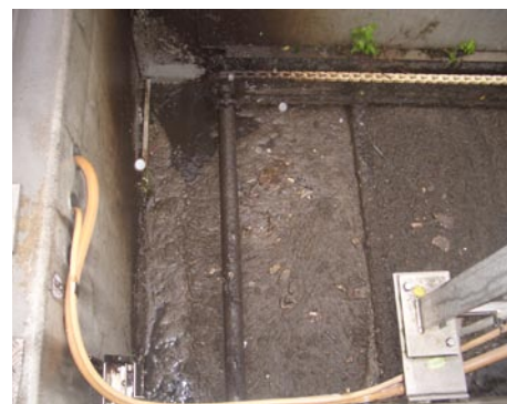
Abb. 38 Absetzbecken Quelle: Informationsbroschüre zum Klärwerk Ruhleben, Berliner Wasserbetriebe
