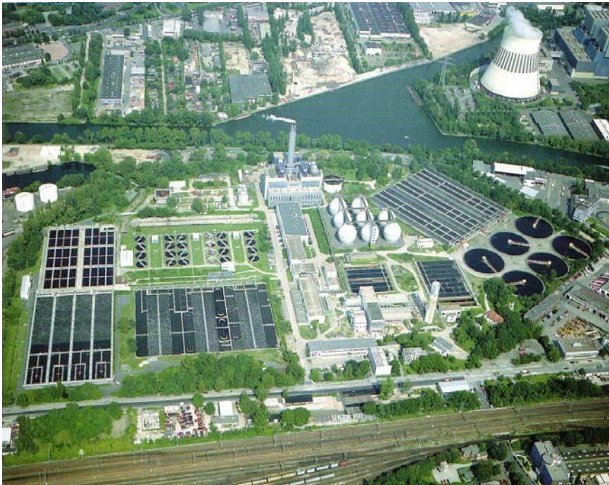
Abb. 19 Luftbild Klärwerk Ruhleben Quelle: Hilmer Bärthel, Geklärt
