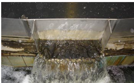
Abb. 37 Gereinigtes Abwasser Quelle: Informationsbroschüre zum Klärwerk Ruhleben, Berliner Wasserbetriebe
