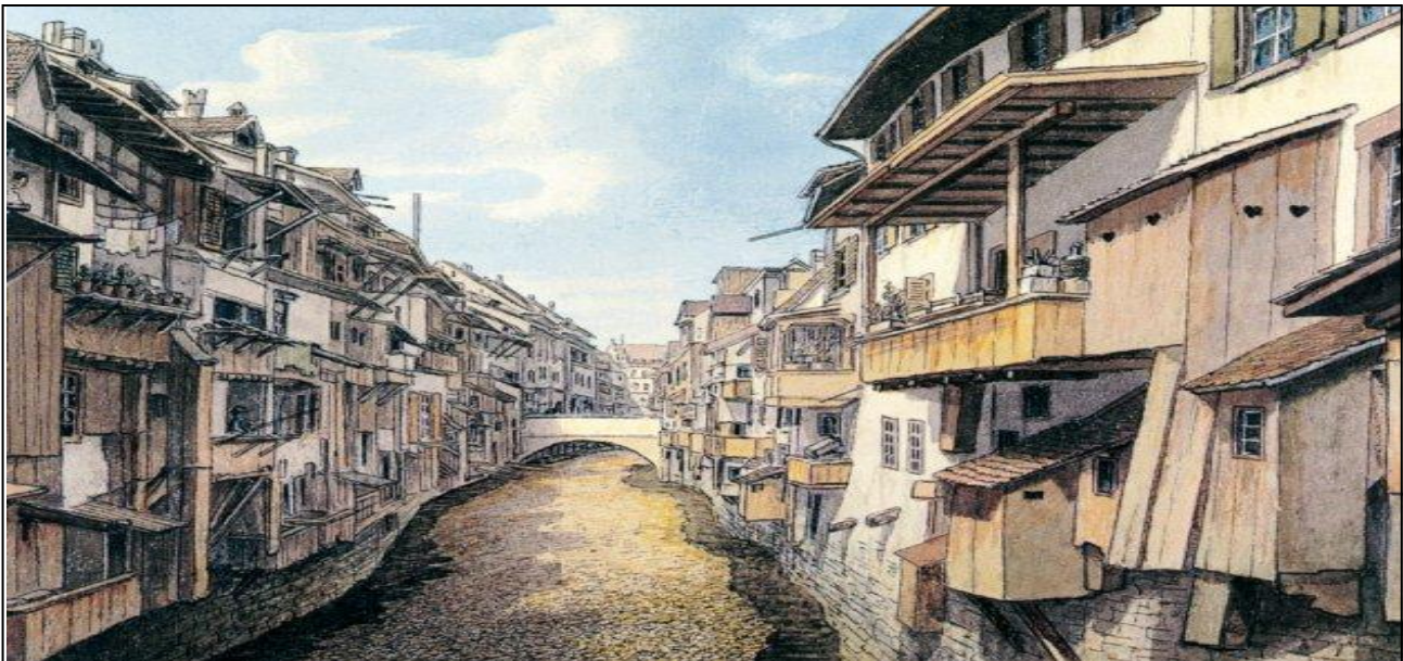
Abbildung 5: Hölzerner Abtritterker über dem Birsig, Basel um 1880
