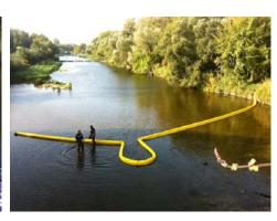
Das Verlegen der WU-Zurrgurt-Oelsperre - hier mit dem Schwimmkörper-Durchmesser von 22 cm - ist sehr einfach. Ebenso das Bilden von Sammel- und Auffangbereichen, auch in Flachwasserbereichen.
