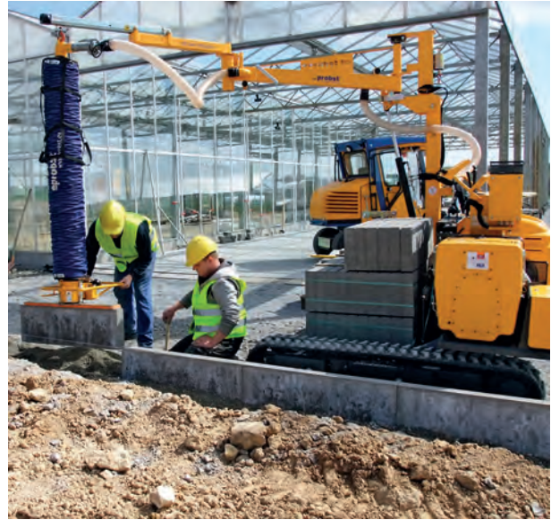
TRANSMOBIL TM Verlegetransporter bei der Bordsteinverlegung
