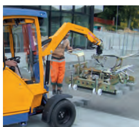
VM-401: Verlegung großformatiger Rechtecksteine
