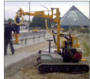
TRANSMOBIL TM Verlegetransporter bei der Plattenverlegung
