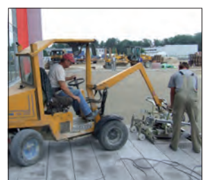
VM-203: Verlegung von großformatigem Pflasterbelag
