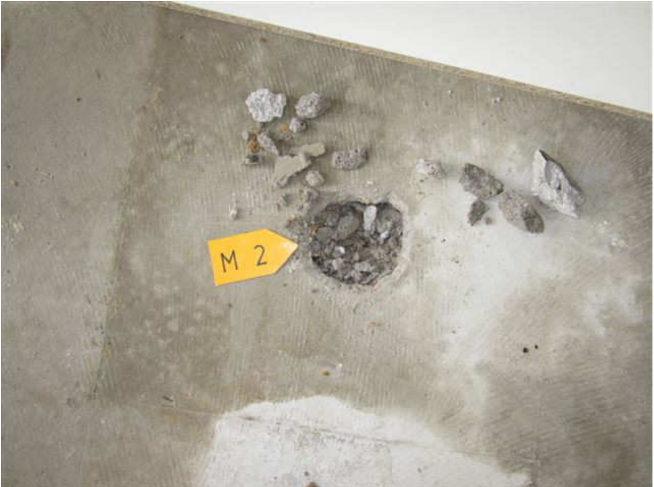
Foto: EG, Raum A011 Probenahmestelle KR-170114-M2
