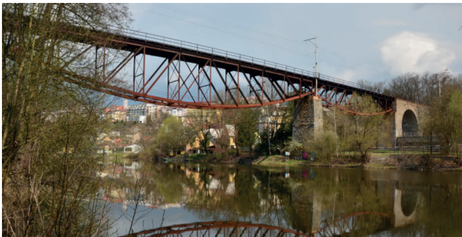
Železniční most přes Lužnici v Táboře, postaven pro Bechyňskou dráhu v roce 1903. V nejbližší době projde rekonstrukcí. Eisenbahnbrücke über die Lainsitz in Tábor, die für die Bechiner Bahn im Jahr 1903 gebaut wurde. Sie wird in der nächsten Zeit rekonstruiert.
