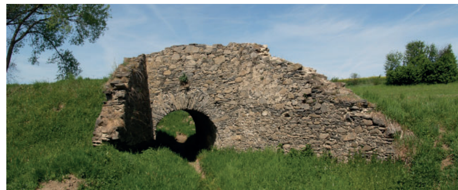
Holkov, Prostřední Svince, násep koněspřežky s klenutým mostem. Holkov, Prostřední Svince, Böschung der Pferdeisenbahn mit einer gewölbten Brücke.
