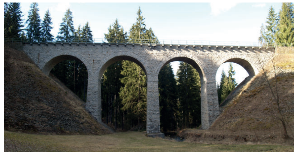
Železniční most Velký Klášterák poblíž Vimperka. Eisenbahnbrücke Velký Klášterák in der Nähe von Vimperk.
