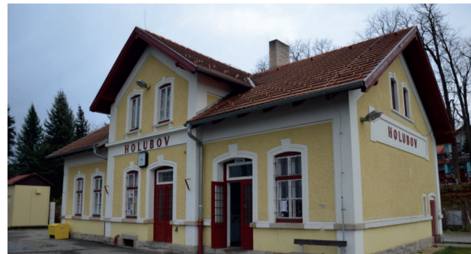
Nádražní budova Holubov na trati Č. Budějovice - Č. Krumlov. Bahnhofsgebäude Holubov auf der Strecke Budweis - Krumau.
