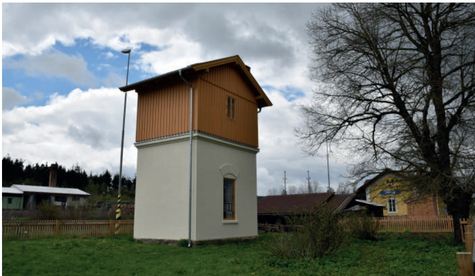
Zbytiny, trať Prachatice - Volary, opravený drážní vodojem. Zbytiny, Bahnstrecke Prachatice - Volary, der renovierte Bahnwasserturm.
