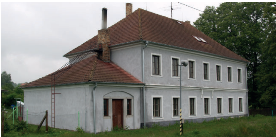
Bujanov, staniční budova koněspřežky, později sloužící jako škola. Bujanov, Stationsgebäude der Pferdeisenbahn, das später als Schule diente.
