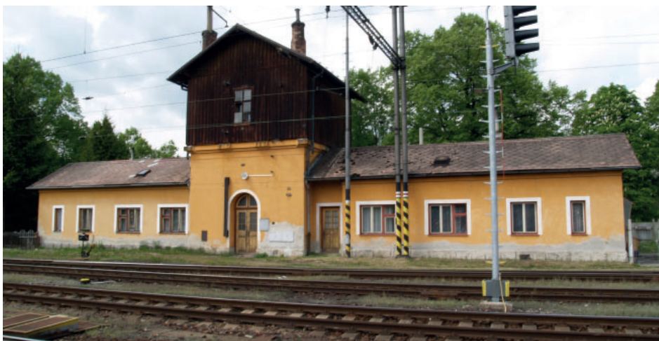
Vodárna ve stanici Jindřichův Hradec. Wasserwerk in der Station Jindřichův Hradec.
