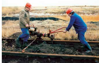
Gleisrückbau am Baufeld Rösa des stillgelegten Tagebaus Goitsche, 1997
