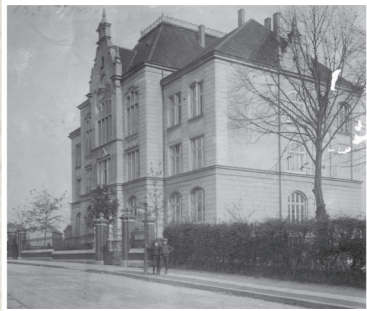
Auf einer etwas jüngeren Fotografie sind die Außenwände verputzt (Stadtarchiv Hattingen)
