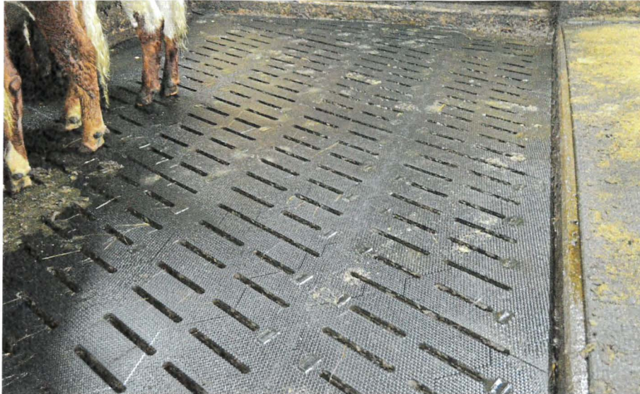
Spaltenauflagen sind in der Regel teurer als Gummimatten für planbefestigte Böden. Erstere müssen zunächst auf die Originalmaße der Spalten zugeschnitten werden.
