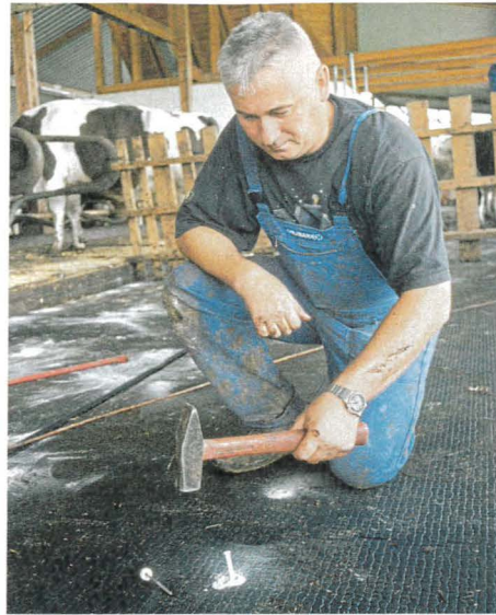
Die Matten für planbefestigte Böden lassen sich einfach mit Dübeln im Boden fixieren.
