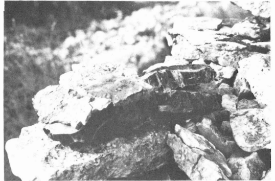
Plattensilex als Einlage in einer ehemaligen Reibergmauer.
