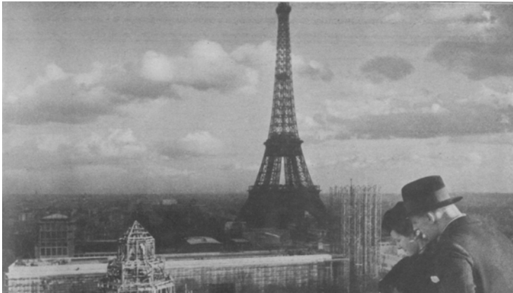
19. Der deutsche Pavillon auf der Pariser Weltausstellung 1937 im Bau, dahinter der Eiffelturm.
