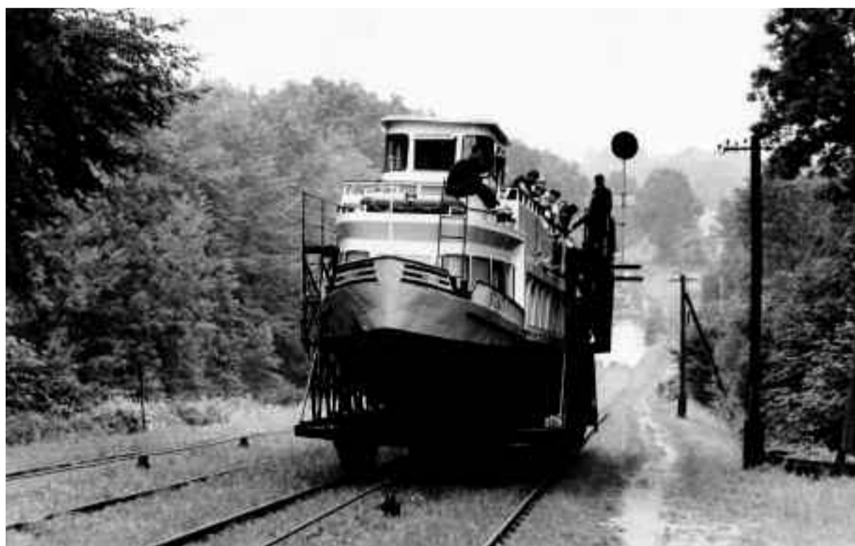
Ein Passagierschiff rollt den Berg hoch: geneigte oder auch schiefe Ebene
