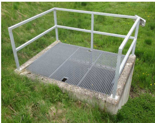
Bild 01/02: Ausführungsbeispiel Absturzsicherung Ablaufbauwerk (li.) und Trennbauwerk (re.)
