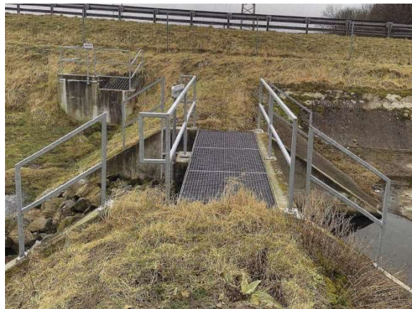
Bild 01/02: Ausführungsbeispiel Absturzsicherung Ablaufbauwerk (li.) und Trennbauwerk (re.)
