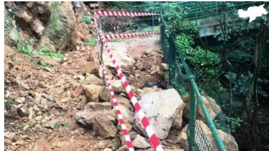
Unterbrechung durch die Mure.
