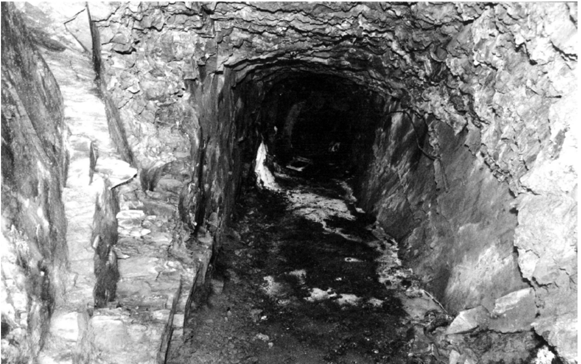
Luftschutzbunker bei Stüttings Mühle
