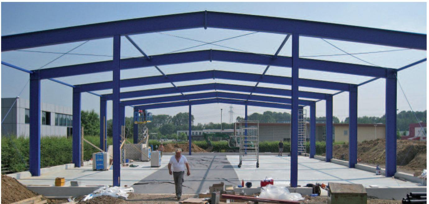
Bild 1: Tragwerk einer typengeprüften Stahlhalle, ProKilo-Markt, Würselen, Spannweite 20 m
