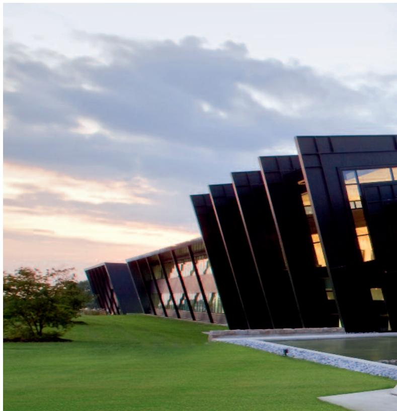
Die formalistische Vorgabe der Architektur ist ein einheitliches Erscheinungsbild der markanten außen liegenden um 15 Grad geneigten Rahmenkonstruktion ohne Verbände und Querverbindungen.
