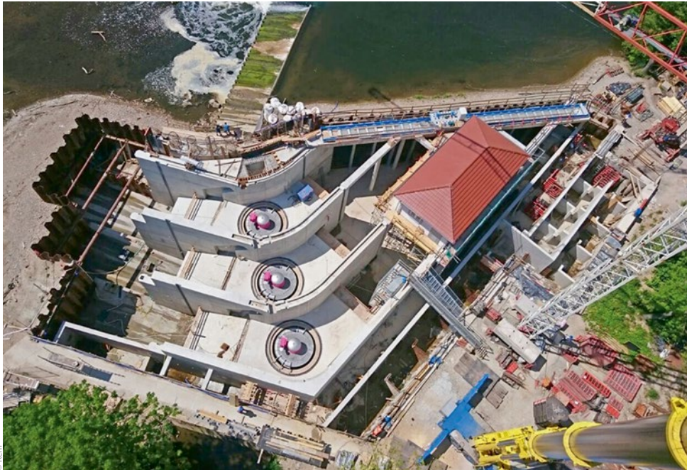
Bild 3: WKA Öblitz mit Leit-rechen-Bypass-System im Bau
