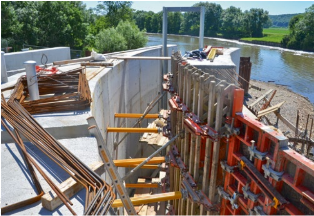
Bild 5: Beide WKA sind mit lichtoffenen, schachtartigen Bypässen ausgestattet, deren Eintrittsprofil die gesamte Höhe der Oberwassersäule erfasst: Bypass der WKA Öblitz im Bau (Blick zum Unterwasser) (links), Bypass der WKA Freyburg (Eintrittsbereich mit Klappe) im Betrieb (rechts)
