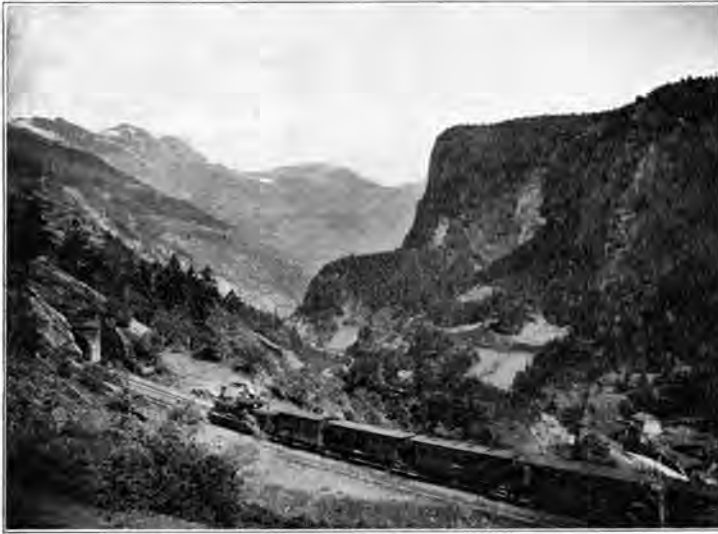
Kanton Tessin: Gotthardbahn bei Dazio Grande.
