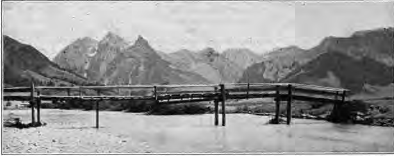
Kanton Schwyz: Brücke über die Sihl bei Euthal, mit Fluhbrig und Ganthöhe im Hintergrund.
