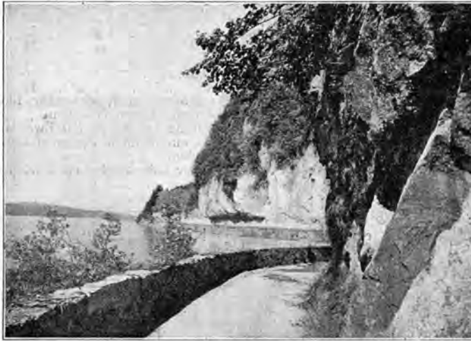
Kanton Unterwalden: Die sog. Kleine Axenstrasse bei Stansstad am Vierwaldst ttersee.
