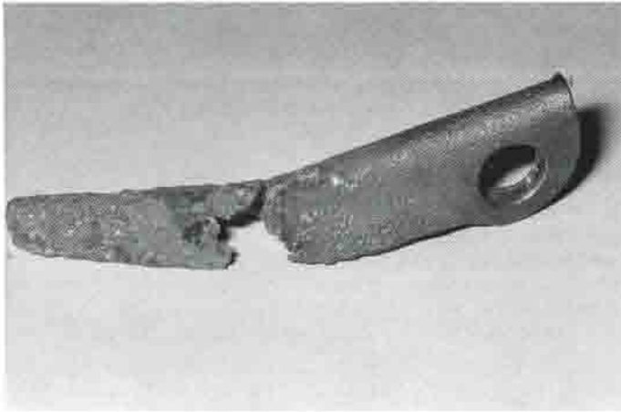
Im Felsriß korrodierter Hakenschaft
