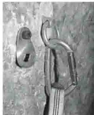
Links: Der linke angerostete Haken wird verschmätzt und deshalb daneben ein neuer gesetzt; auch dieser wird rosten, dann wird ein dritter hinzukommen. Diese Lösung entbehrt jeder Ästhetik. Rechts: Ein neuer Bohrhaken neben zwei alten Bohrkronen im Fels. Wenn es so weitergeht, sieht der Fels bald aus wie ein Schweizer Käse
