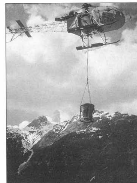
Hubschraubereinsatz beim Materialeilbahnbau
