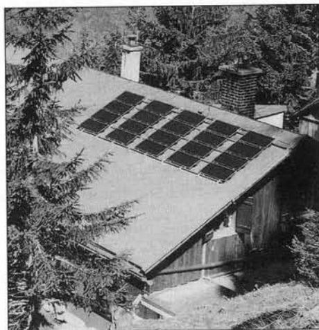
Solaranlage auf der Brunnsteinhütte
