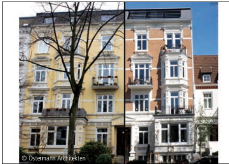
6100-1502 Mehrfamilienhaus, Schwammsanierung Instandsetzung
