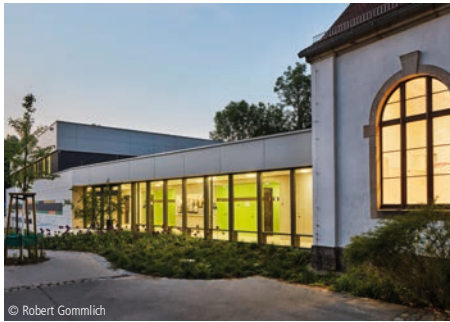
© Robert Gommlich 5100-0129 Sporthalle (Einfeldhalle) Erweiterung
