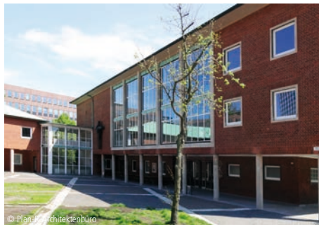
9100-0200 Gemeindehaus (748 Sitzplätze) Umbau
