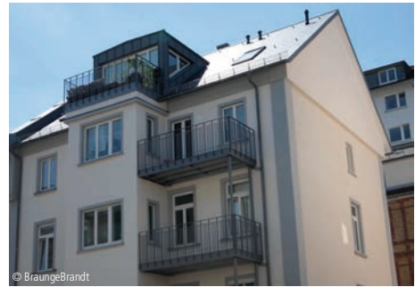
6100-1579 Mehrfamilienhaus, Balkonanlage Modernisierung
