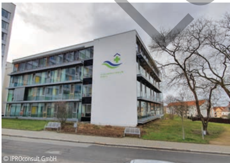
3200-0033 Krankenhaus, Aufstockung Bettenhaus (48 B)
