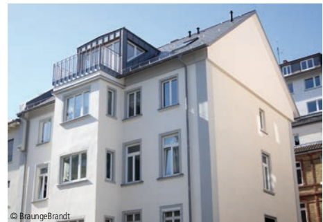
© BraungeBrandt 6100-1267 Mehrfamilienhaus (4 WE), Dachausbau Umbau
