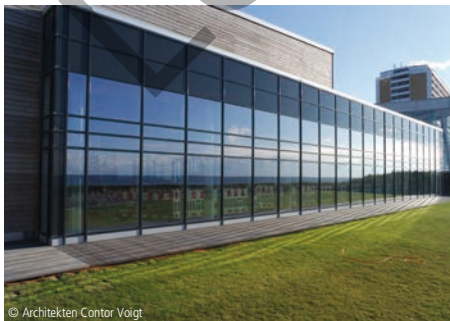
© Architekten Contor Voigt 5200-0012 Sportbadhalle Erweiterung
