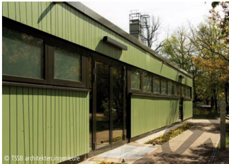
© TSSB architekten.ingenieure 5100-0138 Sporthalle - Sozialtrakt Gebäudehülle Modernisierung
