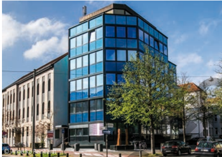
© Angelika Remmert 1300-0247 Bürogebäude Modernisierung 🏠 KISSERARCHITEKTUR Dipl.-Ing. Architekt Gordon Kissler, Isernhagen
