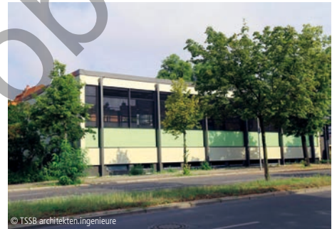
© TSSB architekten.ingenieure 5100-0139 Sporthalle - Halleninnenraum u. Gebäudehülle Modernisierung
