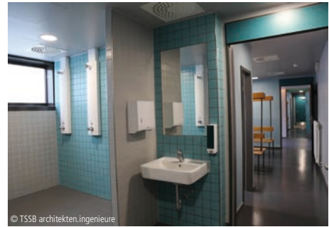
© TSSB architekten.ingenieure 5100-0132 Sporthalle - Sozialtrakt Innenbereich Modernisierung
