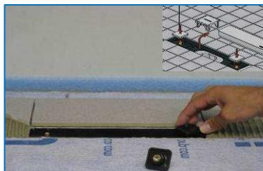
8. Abstandshalter/Rahmenklemmstück nach dem Fliesen entfernen. Durch Drehen die höhenverstellbaren Rostauflagen anschrauben und einstellen.
