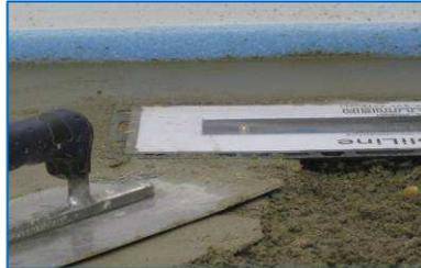
2. Fach- und sachgerechtes Einbringen des Estriches mit einem Gefälle von 2% zum Ablauf hin. Oberfläche bündig mit dem Ablaufgehäuse abziehen. Bauschutzfolie nicht entfernen. Estrich trocknen lassen.
