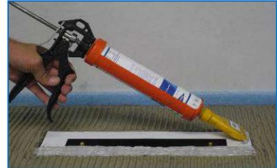
3. Nach Trocknung des Estriches Bauschutzfolie entfernen und die Dichtmanschette aufkleben. Hierzu wird DIBA-COLL auf den vlieskaschierten Flansch aufgetragen. Auf die restliche Estrichfläche wird Flexklebemörtel appliziert.
