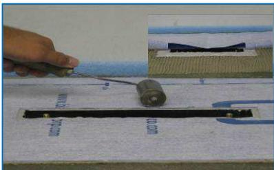
4. Dichtmanschette in den frischen Kleber einlegen und faltenfrei andrücken. Überschüssigen Kleber am Ablaufgehäuse entfernen. Restliche Bodenfläche mit Verbundabdichtungssystem, wie z. B. Blanke•DIBA 100 abdichten.
