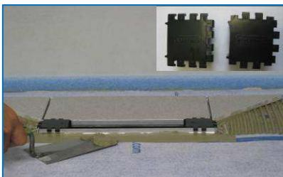
7. Bei der Verwendung von Fliesen-schienen 6 – 12 mm ist das Rahmenklemmstück abzulängen. Für eine Rahmeneinfassung sind je zwei Schienen mit je 300 mm und 2 x 58 mm zuzuschneiden. Schienen mit Rahmenklemmstück einklipsen und an die Rinne legen. Die Profile werden mit dem Dünnbettmörtel eingeklebt.
