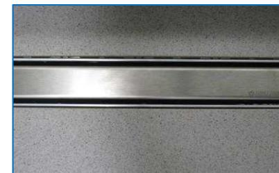
9. Rost bündig mit der Fliesenoberfläche auflegen. Bei Einfassung der Fliese mit Profilen kann die Fuge zwischen Fliese und Profil mit Fugenmörtel geschlossen werden.
