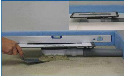
1. Der längliche Bodenablauf wird an gewünschter Stelle positioniert und fixiert. Ablauf an Hausentwässerung DN 50 anschließen. Die Ablaufleitung muss ein Gefälle von 2% aufweisen. Rohrverbindungen auf Dichtigkeit prüfen.
