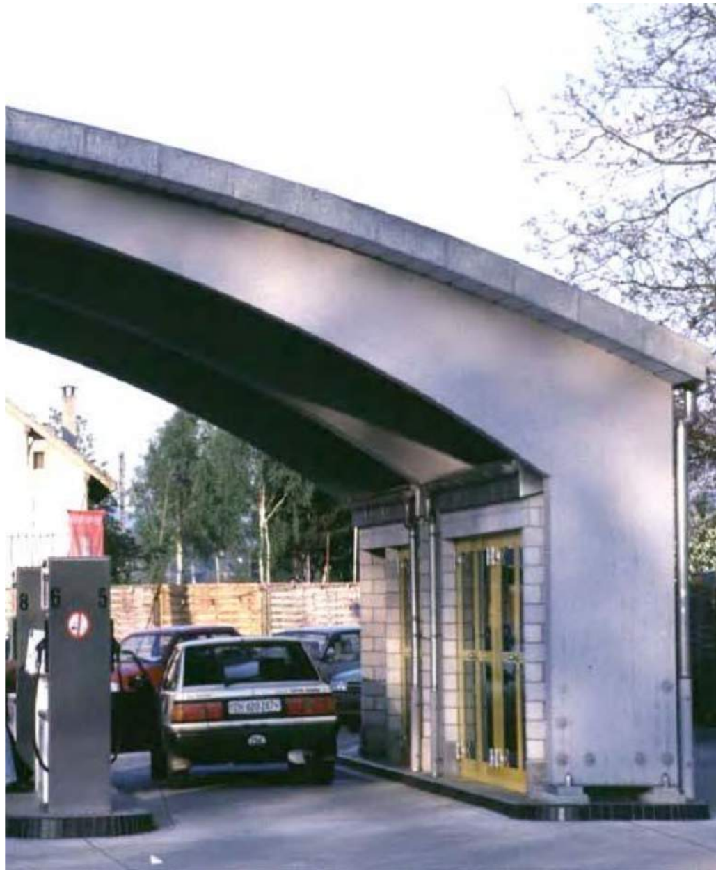
Eingespannter Stützenfuss im Holzbau
