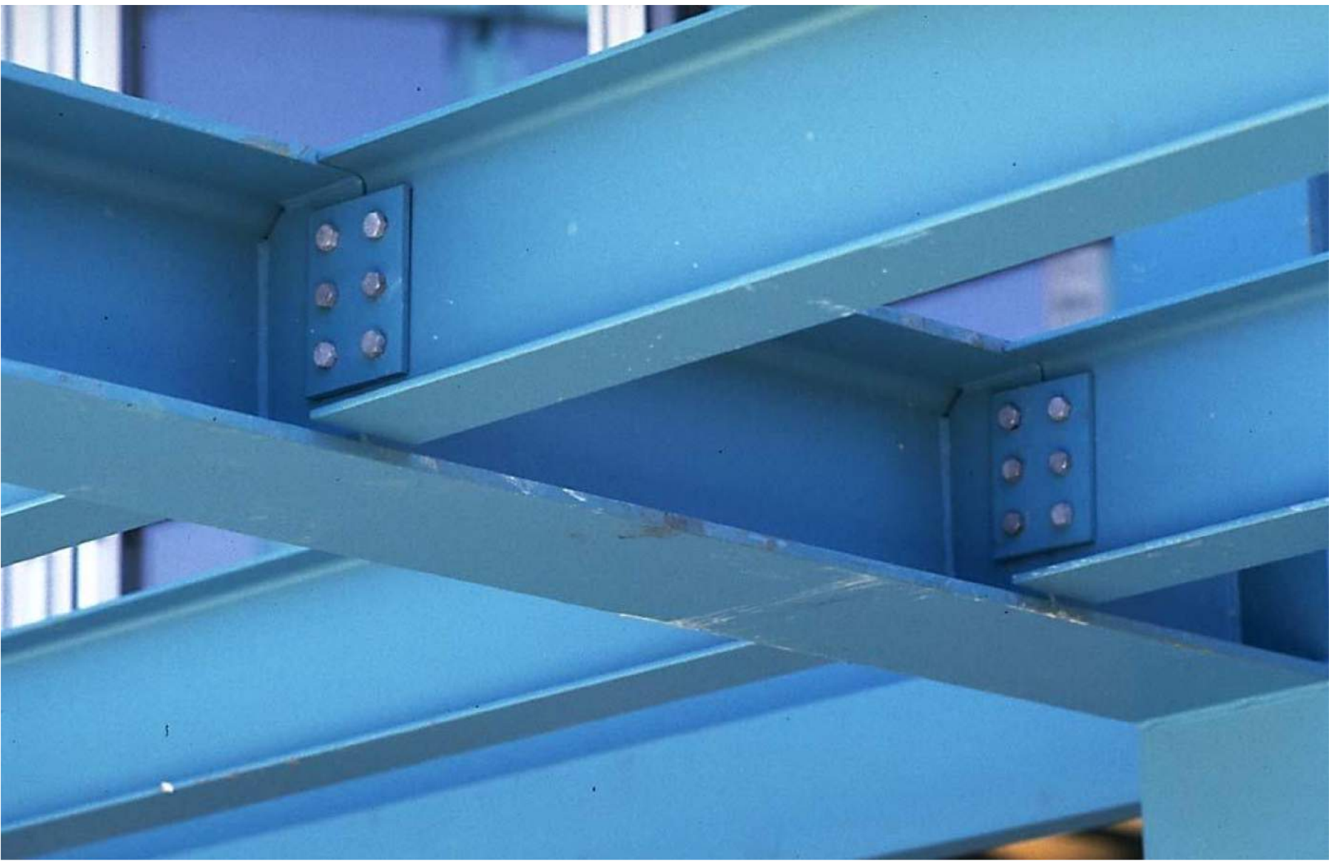
Querkraftverbindungen im Stahlbau Träger - Träger
