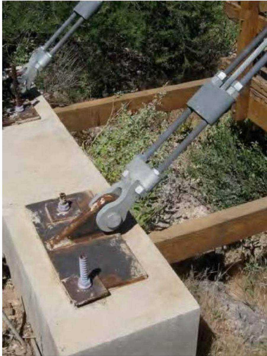
Verankerungen von Zuggliedern im Stahlbetonbau
