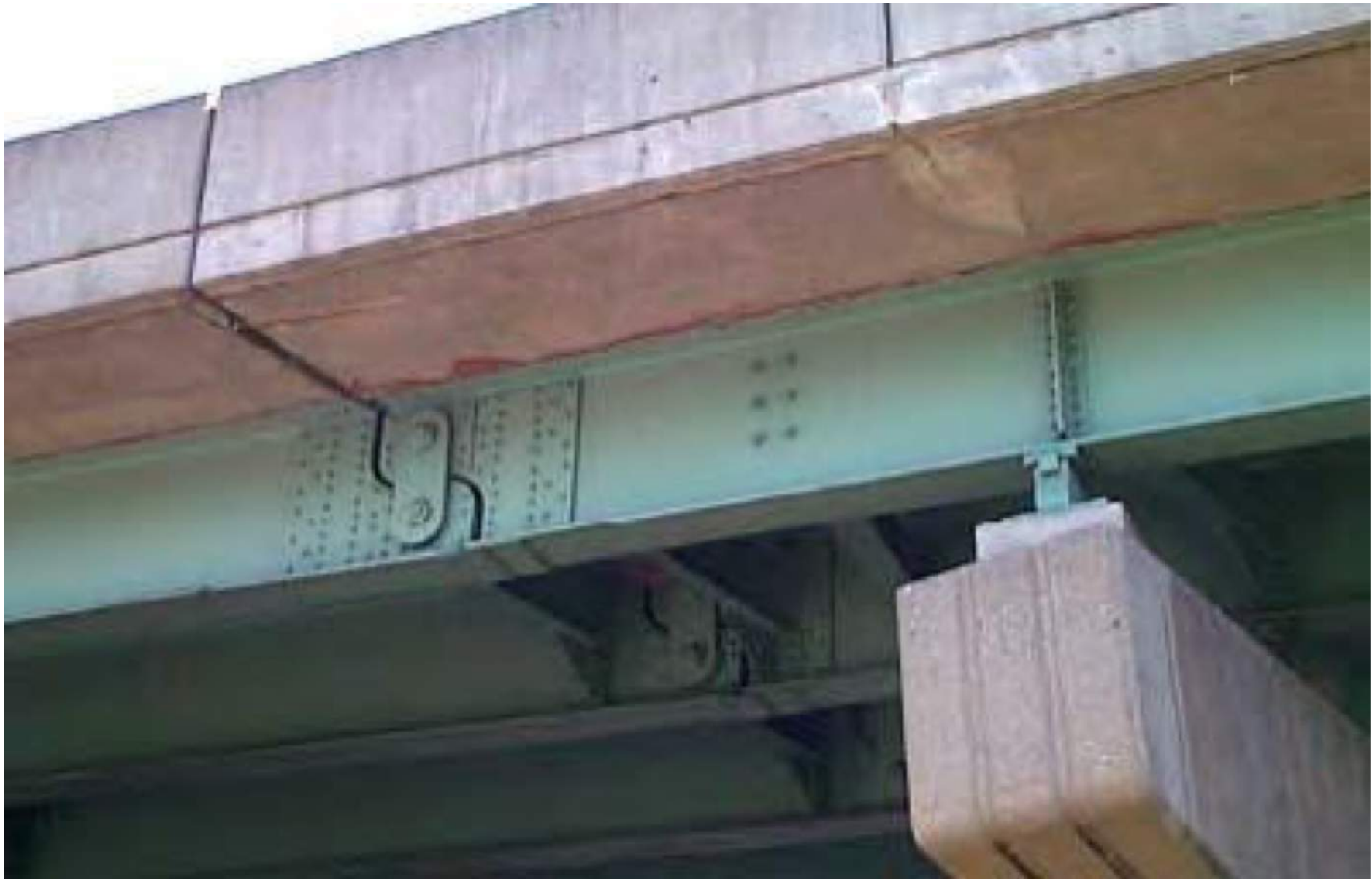
Gelenke im Stahlbau
