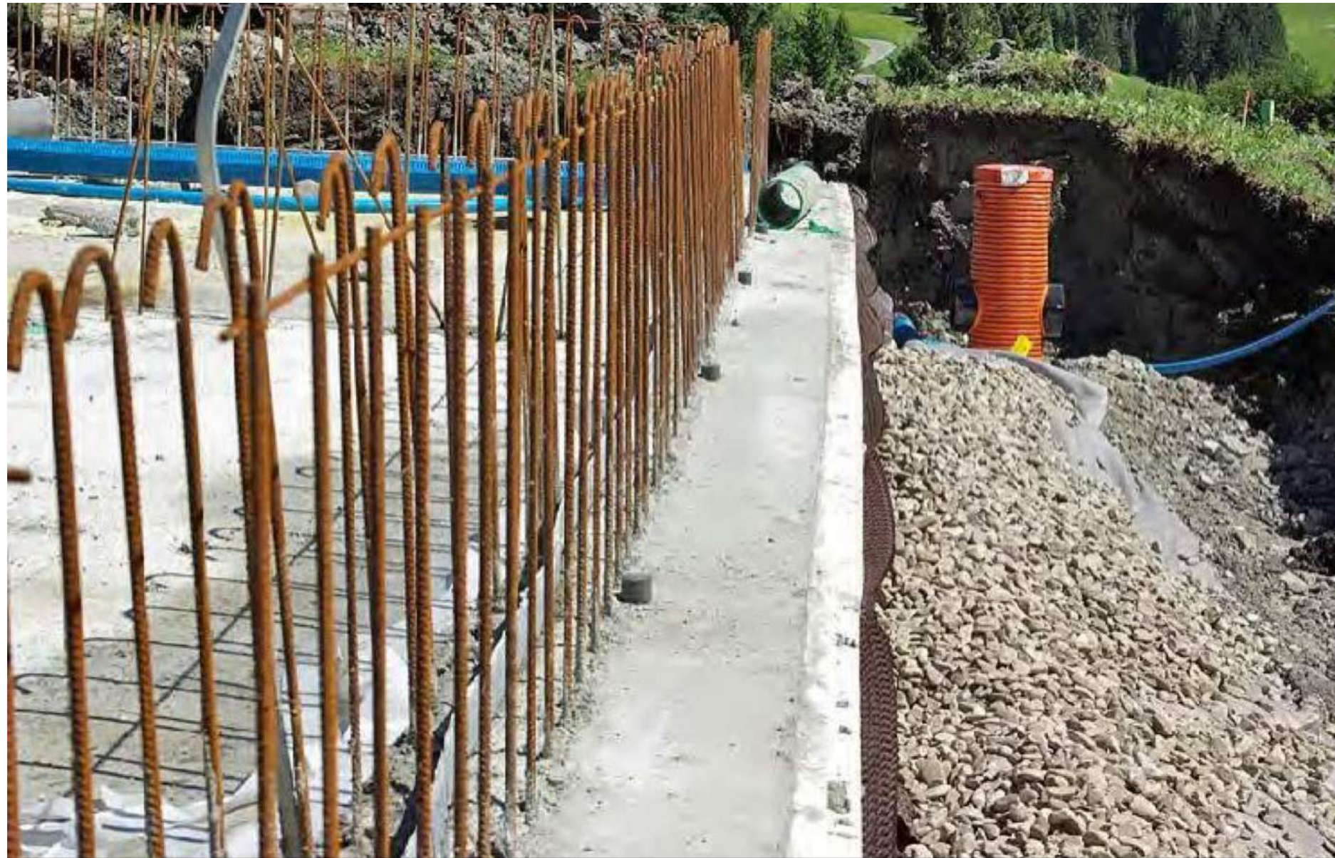
Biegesteife Verbindungen im Stahlbetonbau
