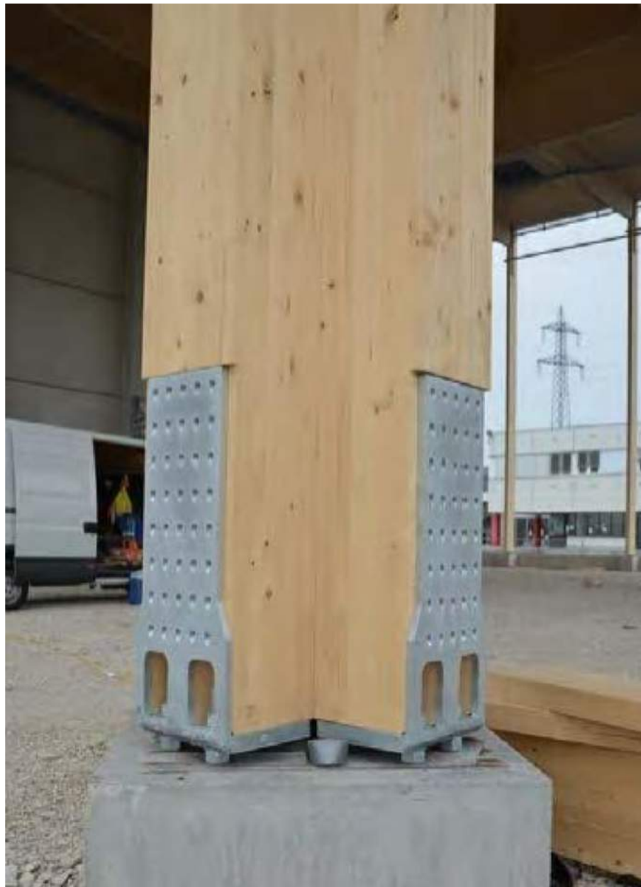
Gelenkige Stützenfüsse im Holzbau
