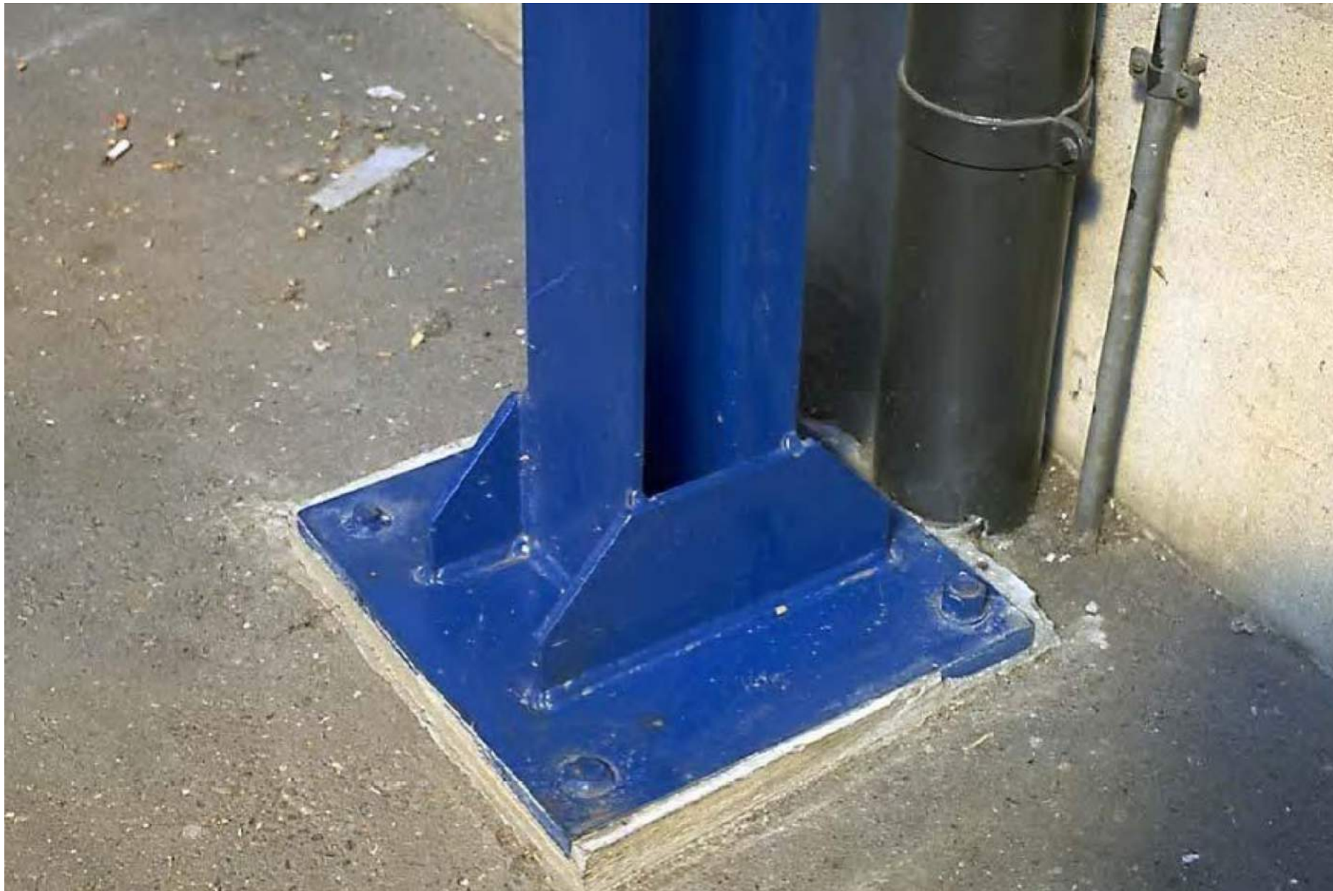
Biegesteifer Stützenfuß im Stahlbau
