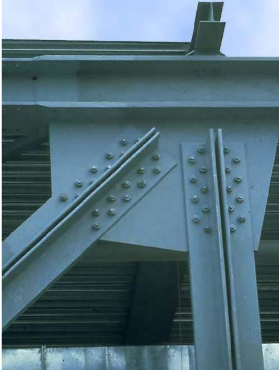
Fachwerkknoten im Stahlbau
