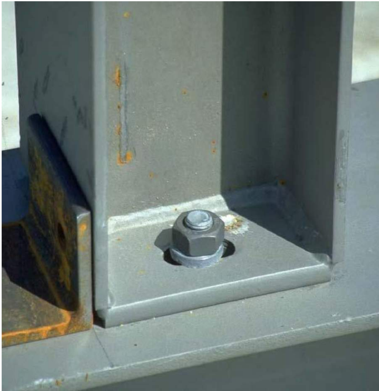
Gelenkige Stützenfüsse im Stahlbau
