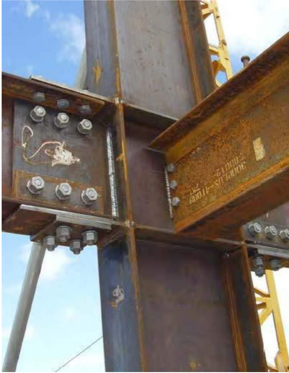
Querkraftverbindungen im Stahlbau Träger - Stütze
