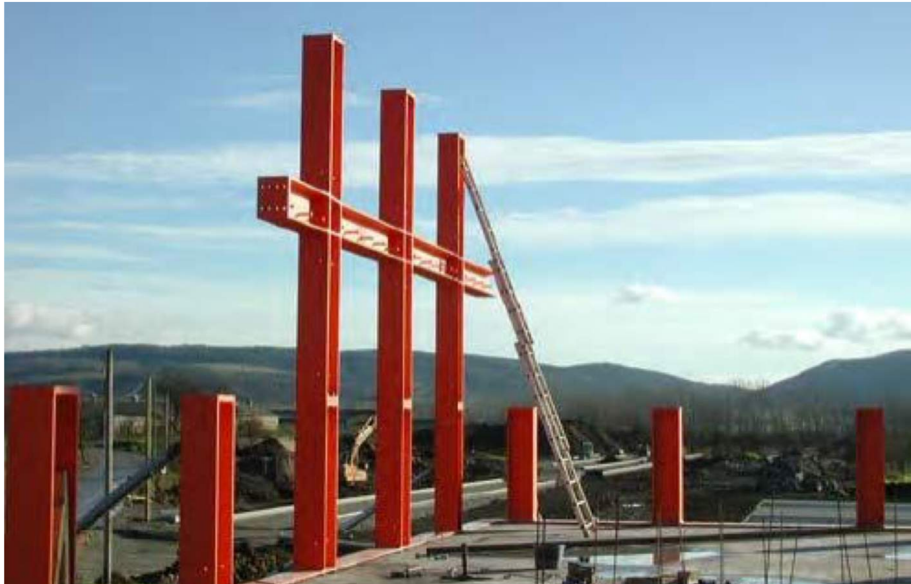
Biegesteifer Stützenkopf im Stahlbau
