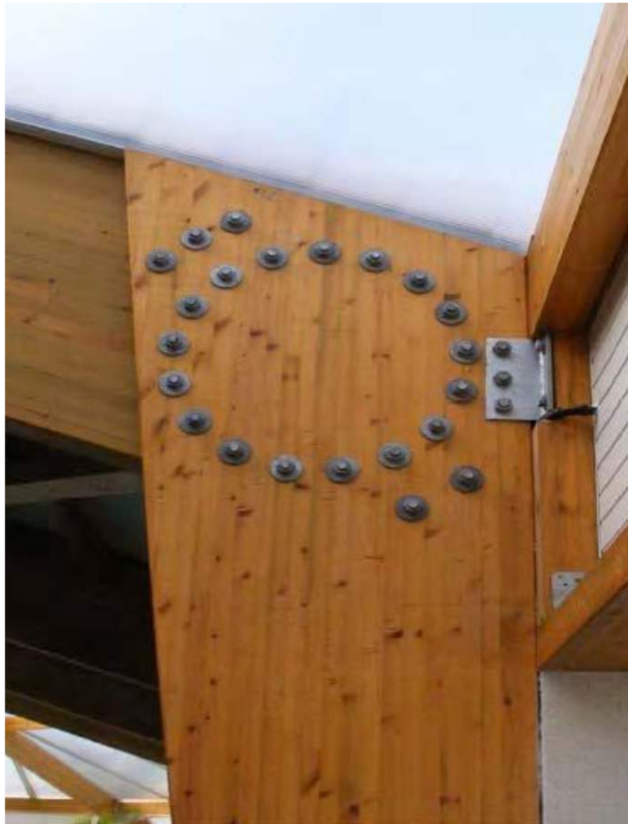
Biegesteife Verbindungen im Holzbau
