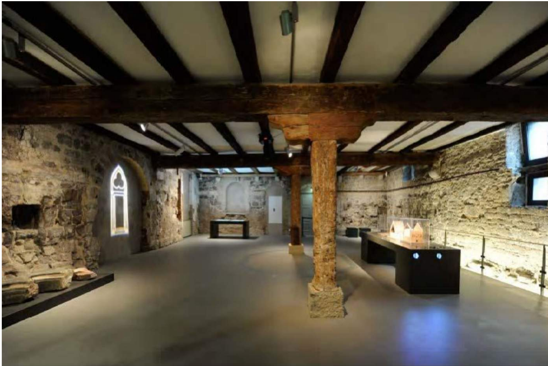
Stützenköpfe im Holzbau
