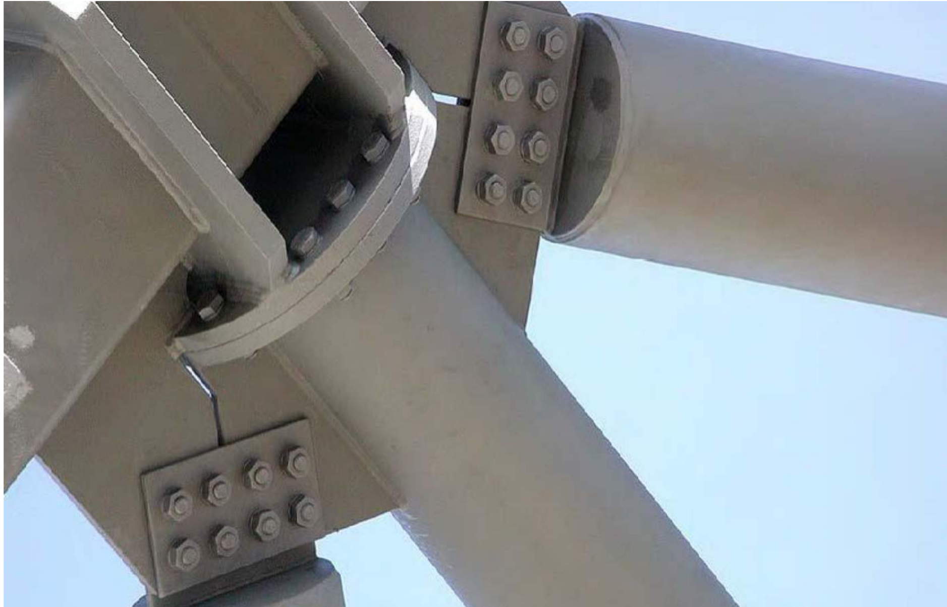
Verankerung von Zuggliedern im Stahlbau
