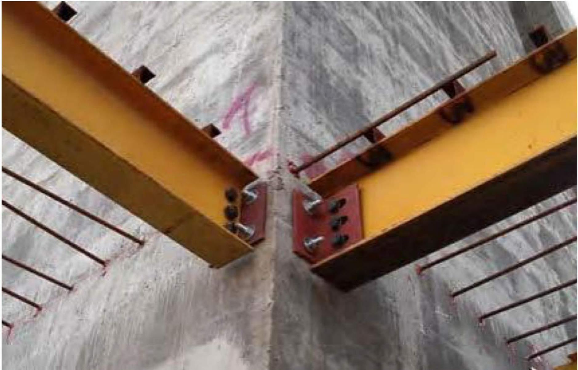
Querkraftverbindungen im Stahlbetonbau
