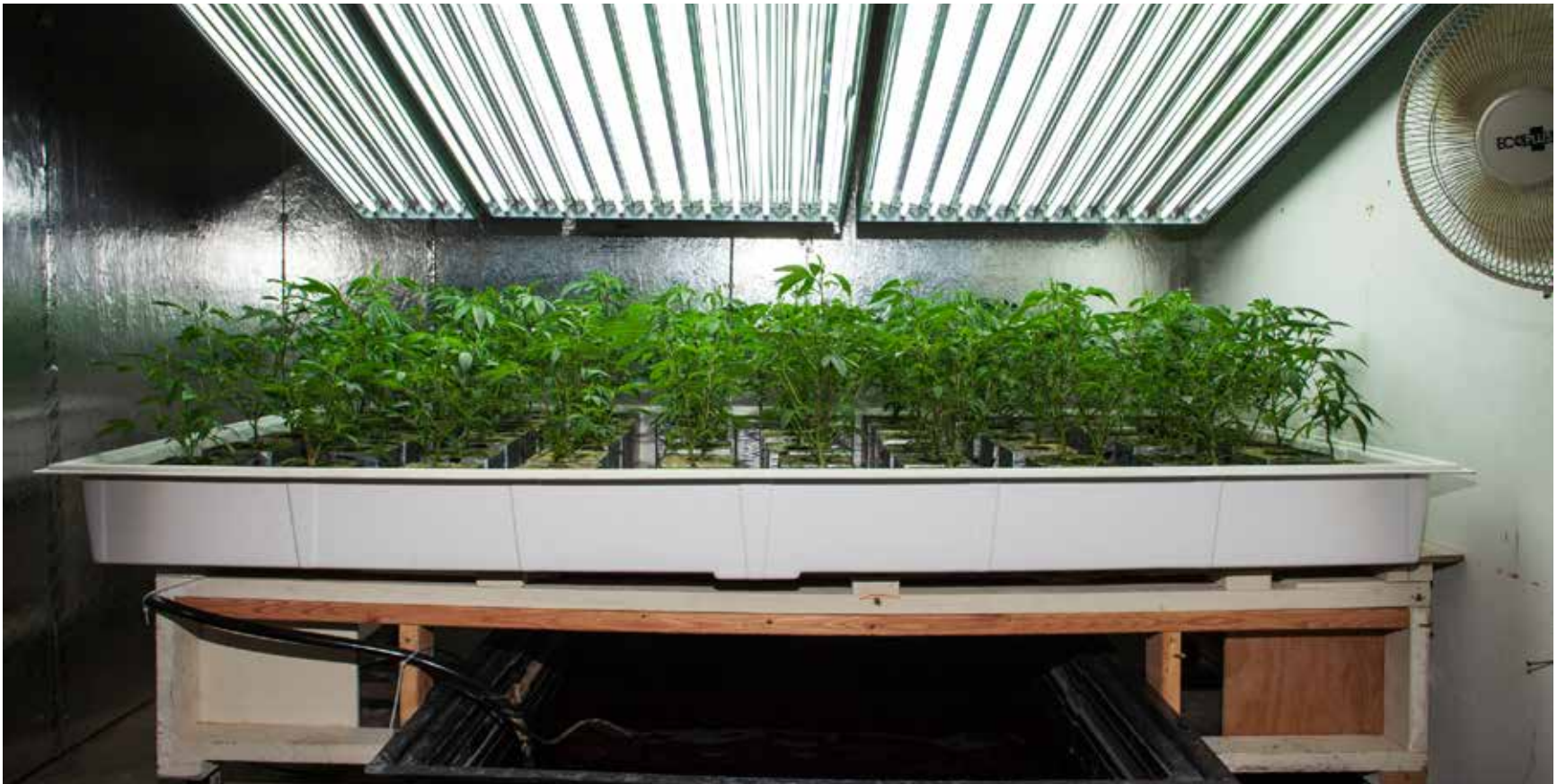
Die T-5-Leuchtstoffröhren werden schwächer und dann durch LED-Leuchten ersetzt.
