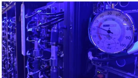
*Der Kühlkreislauf des VSC-4: Mit rund 45 Grad trifft das Wasser auf die Hardware, mit 48 Grad kommt es wieder heraus. Die Hitze wird in einem Wärmetauscher abgeleitet und aufs Gebäudedach geschickt.*
