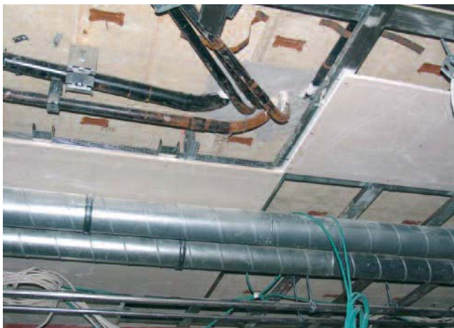
Abb. 4: Geplante Nachrüstung durch eine F 90-Unterdecke (allein)
