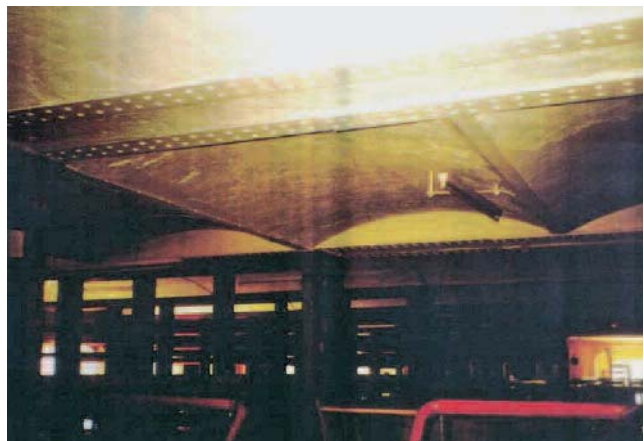
Abb. 3: Kappendecke in einem mehrgeschossigen Bauwerk
