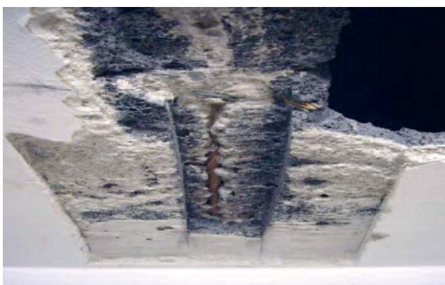
Abb. 13: Deckenansicht der Decke nach Abb. 12
