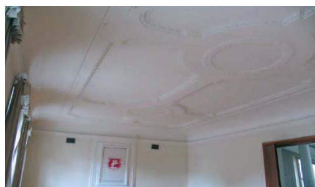
Abb. 14: Stahlbetondecke in einem alten Verwaltungsgebäude (Denkmalschutz)
