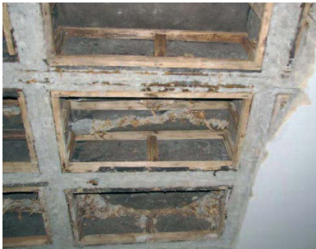
Abb. 1: Rippendecke mit Schalkkörpern, HWL-Platten und Putz
