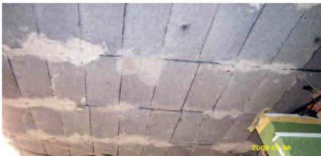
Abb. 9: Stahlbetonbalkendecke mit Füllkörpern (laufen unter Träger durch)
