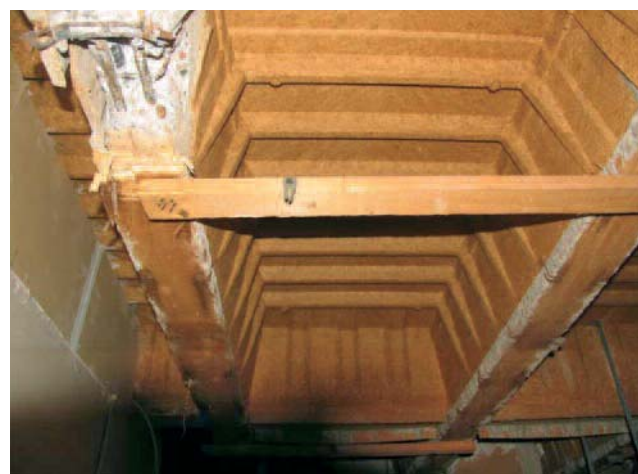
Abb. 6: Rippendecke mit verllorener Holzschalung
