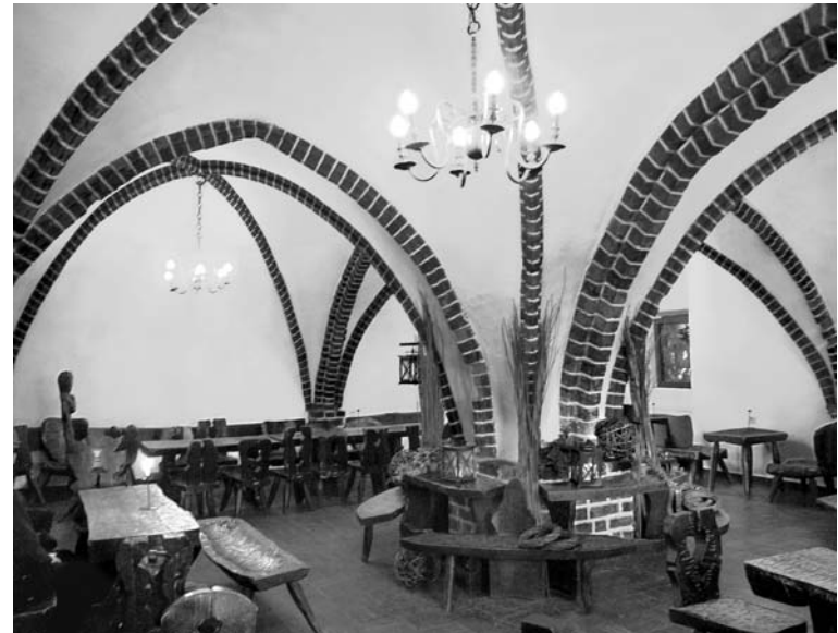
22 Rekonstruierter Gewölberaum im Erdgeschoss. Aufnahme 2008 Zrekonstruowana sala ze sklepieniami na parterze, zdjęcie z roku 2008
