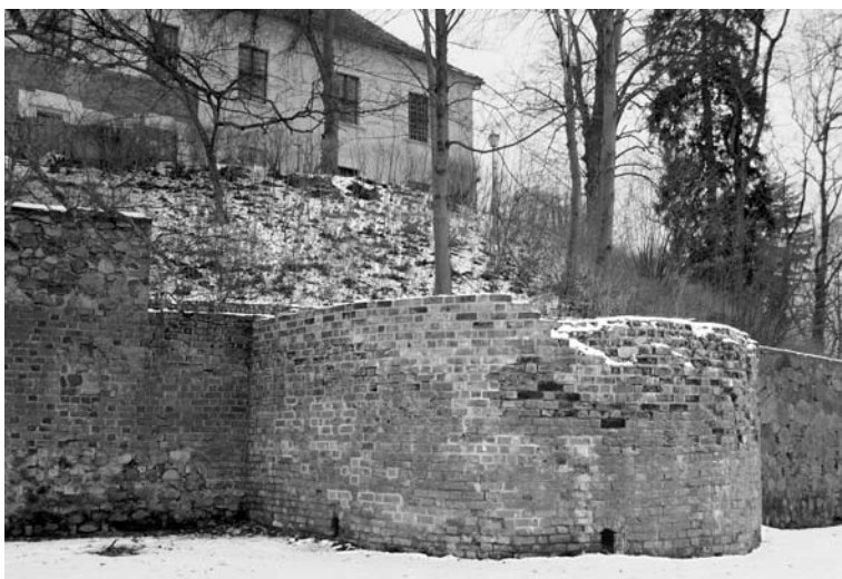
6 Ehemalige Rundbastion in der nördlichen Zwingermauer der Komturei. Aufnahme 2008
