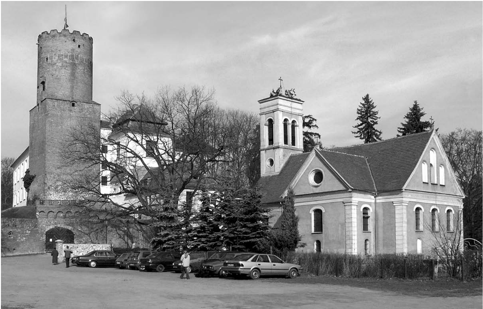
26 Gesamtansicht von Burg und Kirche. Aufnahme 2008 Widok całościowy zamku i kościoła, zdjęcie z roku 2008
