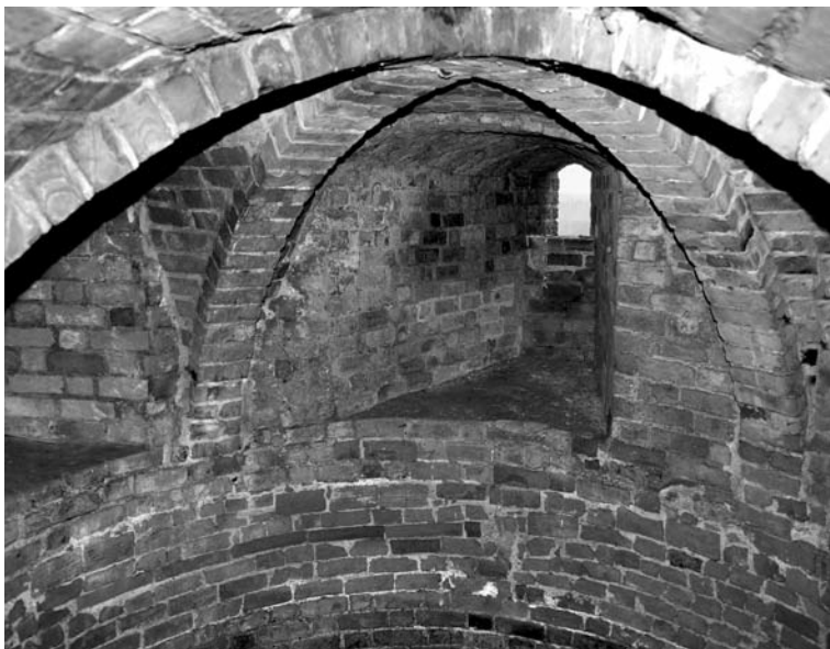
19 Mittelalterliche Schießscharte im nachträglich aufgesetzten Rundturm. Aufnahme 2008
