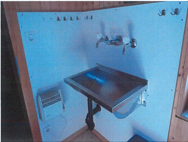
Waschgelegenheit im Obergeschoss
