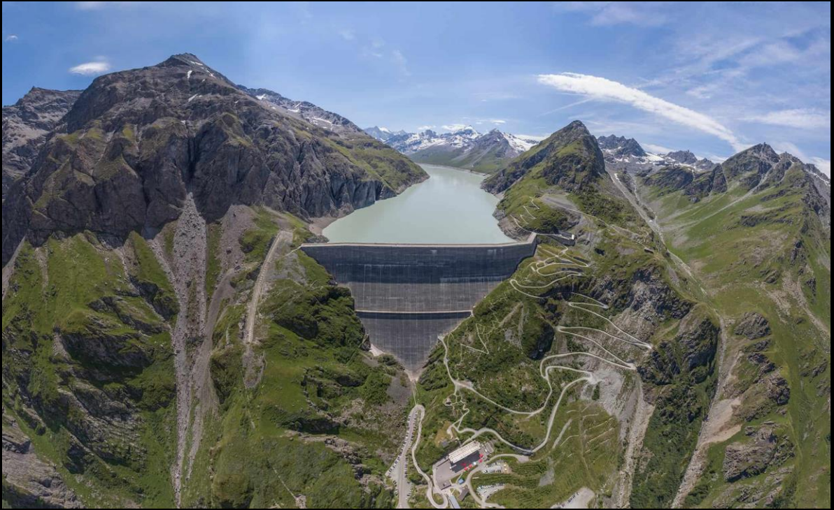
Staumauer Grande Dixence (1951-1965, Höhe 285 m)
