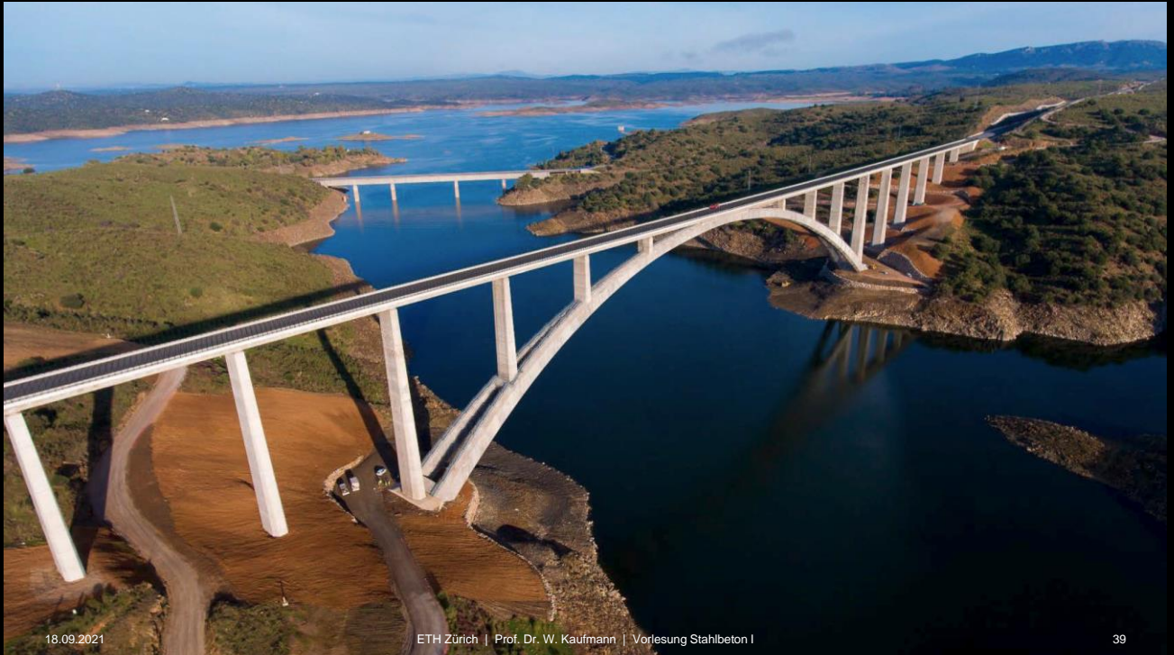
Viaducto de Almonte (2017, L= 384 m), Arenas&Asociados (Foto ebenfalls).
