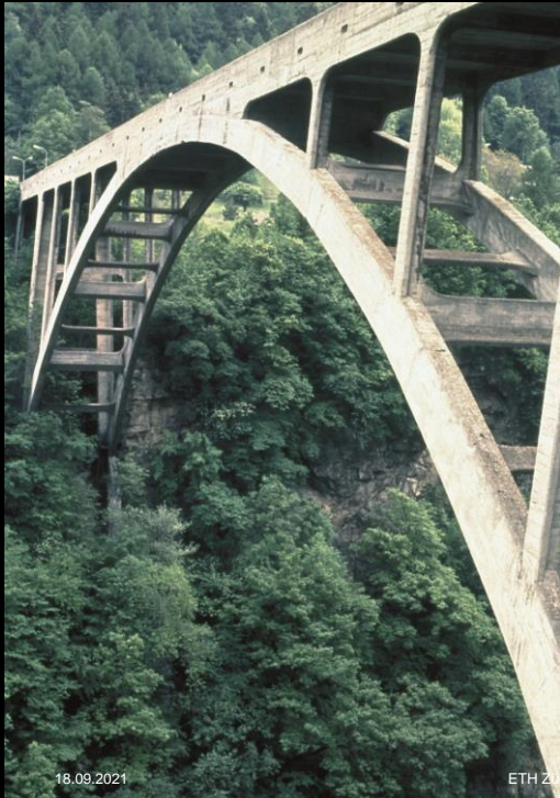
Pont de Gueuroz, Vernayaz (1934, l = 99\text{m} , L = 168\text{ m} ); Pont de Meryen, Stalden (1930, L = 118\text{ m} ). Alexandre Sarrasin.
