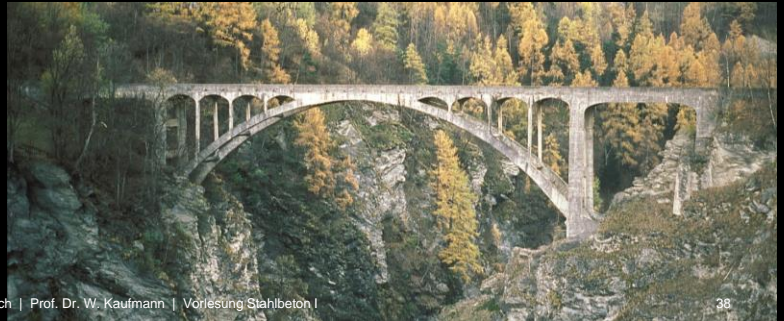
Pont de Gueuroz, Vernayaz (1934, l = 99\text{m} , L = 168\text{ m} ); Pont de Meryen, Stalden (1930, L = 118\text{ m} ). Alexandre Sarrasin.
