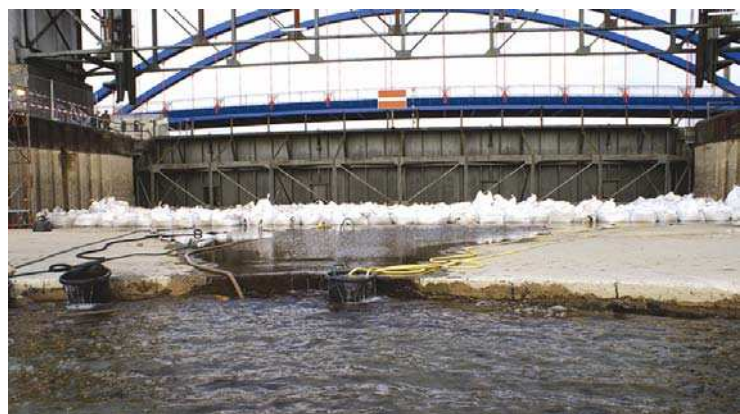
Bild 2: Sperrtor Schlieker mit entleertem Kanal
