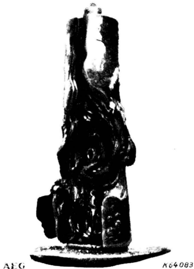
Bild 2. Durchschlag einer Durchführung.
