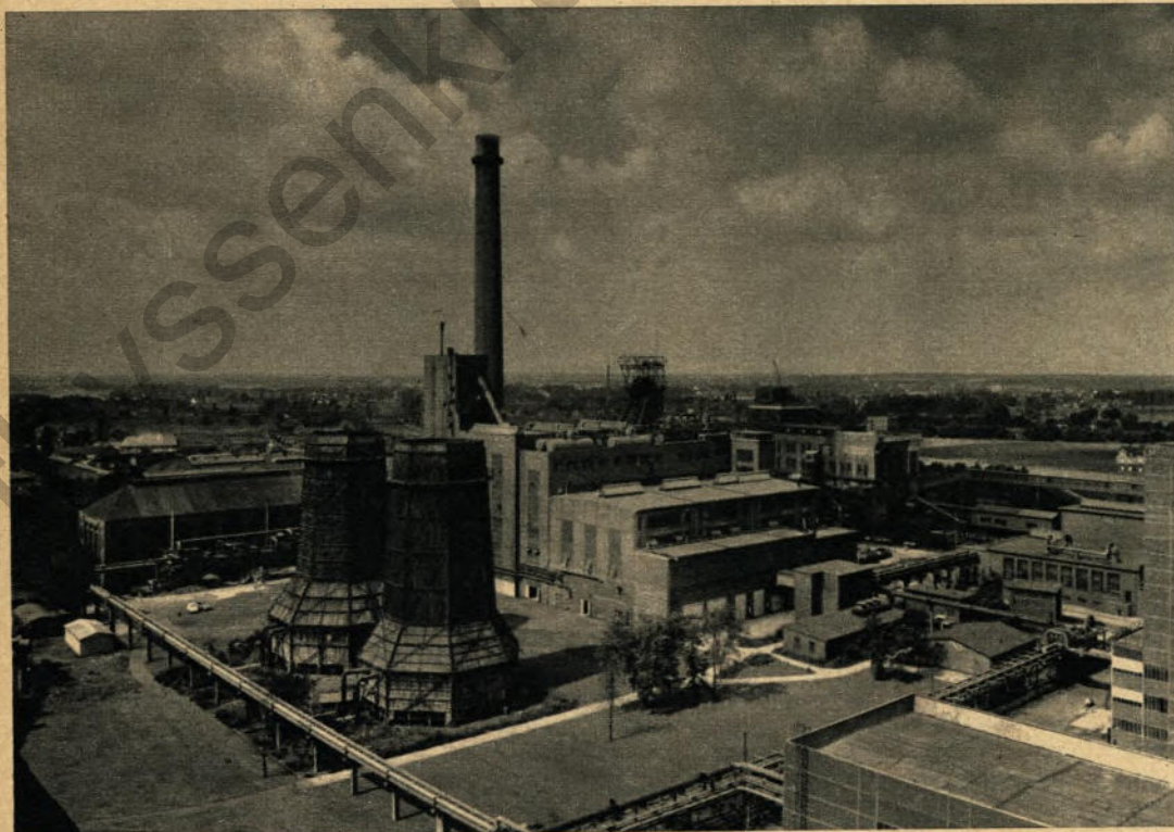
Um einen von Konjunkturschwankungen unabhängigen Kohlenabsatz zu sichern, entstand auf der Schachtanlage Fürst Leopold-Baldur ein Hochdruckkraftwerk, das die schwer absetzbare Ballastkohle verwertet (links). Ebenso wie das Kraftwerk verbraucht auch eine neben der Schachtanlage errichtete Druckvergasungsanlage der Steinkohlengas AG regelmäßig Leopold-Kohle (oben)
