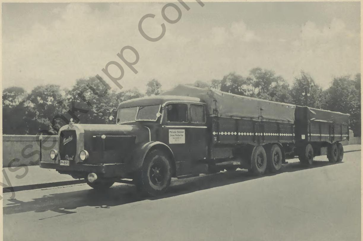
Dreiachs-Schwerlastwagen für 9 (mit Anhänger bis zu 20) Tonnen Nutzlast
