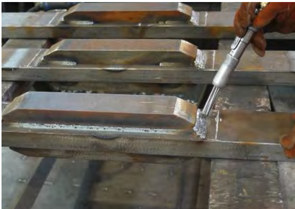
Bild 7-12:Schweißen der Prüfkörper: Messen von Zwischenlagentemperaturen (o.l.), Schweißen der Flankennaht (o.r.) und (m.r.), Stirnnaht wie geschweißt und ungereinigt (m.r.), Entfernen von Schlackeresten mit Nadelpistole (u.l.), Stirnnaht im Schweißzustand belassen (u.r.)
