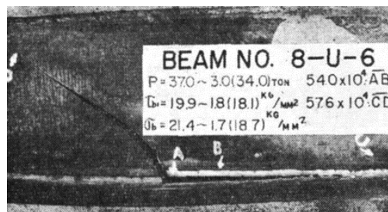
Bild 6-136: Geschweißter I-Träger mit Ermüdungsriss infolge Schubbeanspruchung der längsverlaufenden Kehlnähte [#297]
