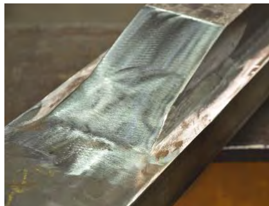
Bild 7-13: Bearbeitung der Oberfläche mit Winkelschleifer (o.l.), Oberfläche nach grober Bearbeitung (o.r.), Nachbearbeitung mit Rollenschleifer (u.l.), kerbfrei bearbeitetes Gurtlamellenende (u.r.)
