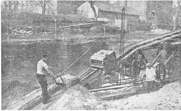
Rys. 3. Przenośnik taśmowy z mechaniczną łopata.
