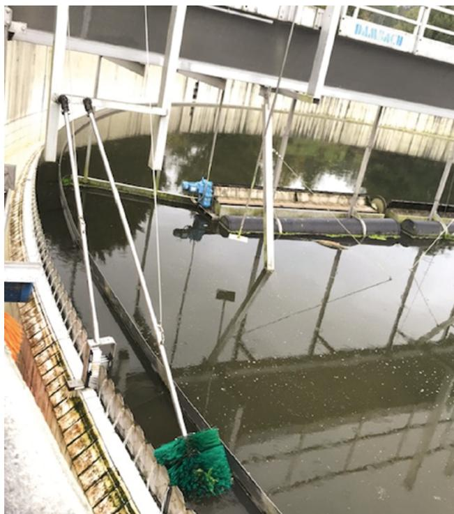
Abb. 2: Befestigung des Bürstensystems
