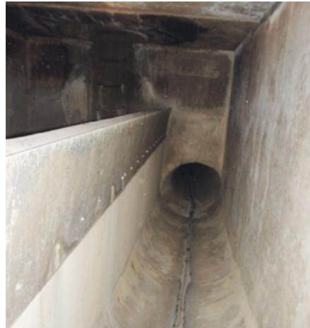
Abb. 3: Wehr, nachträglich mit Edelstahlschwelle ausgerüstet
