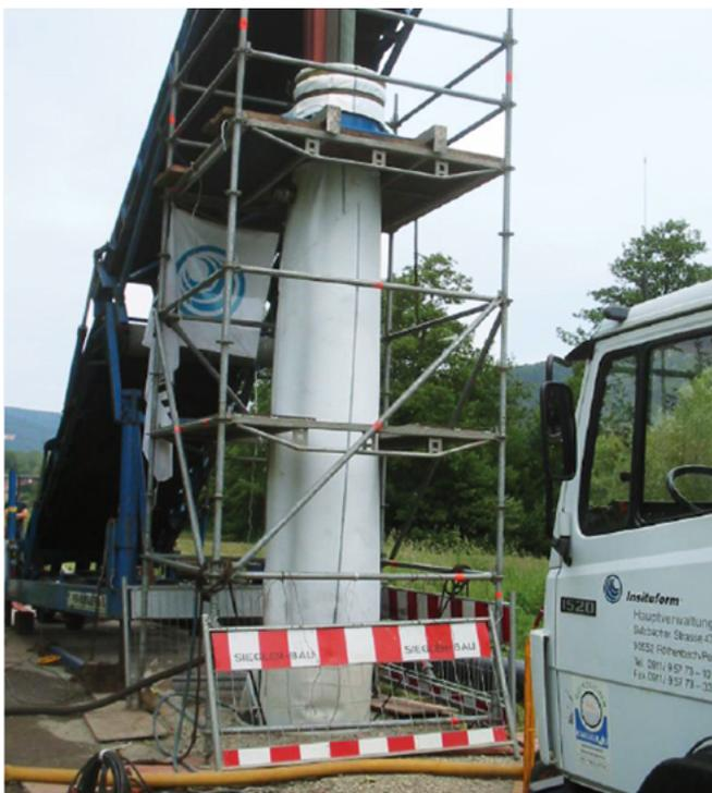
Abb. 4: Der Inliner wird eingezogen.
