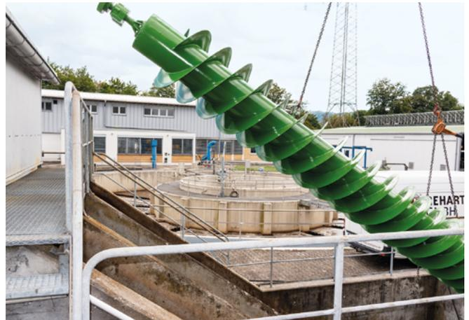
Abb. 6: Einbau der sanierten Hebeschnecke
