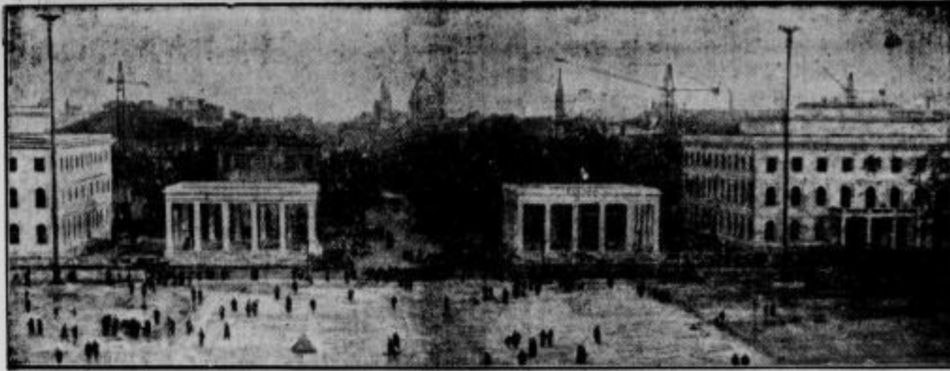
Am 3. November wird das Richtfest der Neubauten der R.S.M.P. am Münchener Königsplatz feierlich begangen. Der neugegestaltete Münchener Königsplatz gehört jetzt zu
