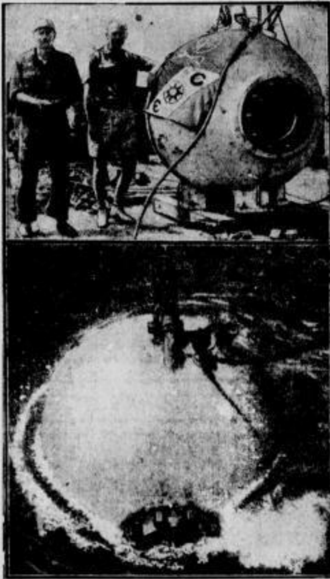
Die Taucherfluge des Amerikaner Bebe, mit der der Forscher fast 1000 Meter unter dem Meeresspiegel hinunterging. (Wagenberg-Archiv - M.)
