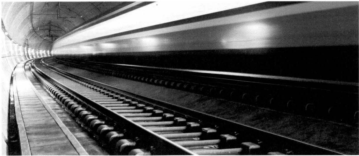
Feste Fahrbahn im Betrieb im Grauholtzunnel (Bahn 2000; Bild: SBB)
