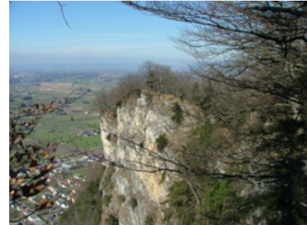
Abb. 3.11: Schloßberg Nordgrat mit Felsabbruch.
