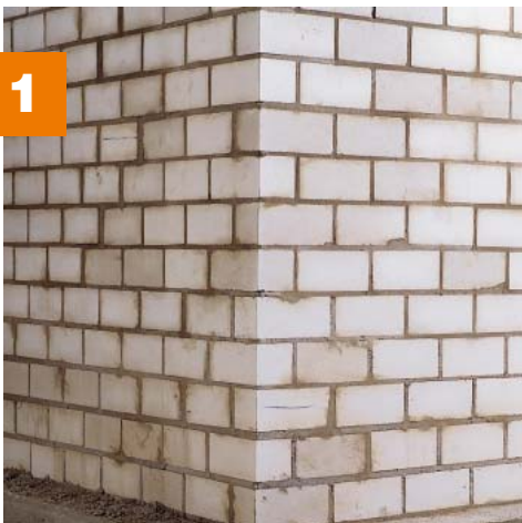
1 Eine unverputzte Kelleraußenwand aus Kalksandsteinen. Vor Auftrag einer Dickbeschichtung müssen offene Fugen geschlossen werden. Der Untergrund muss tragfähig, oberflächentrocken, saugfähig, frostfrei und frei von Verunreinigungen sein.
