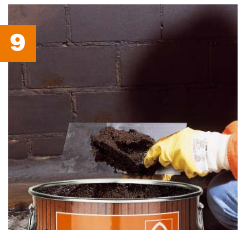
9 Nach Durchtrocknung des Voranstriches (ca. 24 Stunden) wird mit dem Auftrag der Dickbeschichtung begonnen. Dazu wird das Material mit einer Maurerkelle aus dem Gebinde geholt und auf die Rückseite des Glätters gelegt.
