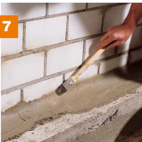
7 An den Übergängen zwischen Mörtel und Untergrund wird mit einem feuchten Pinsel der Anschluss glattgestrichen.
