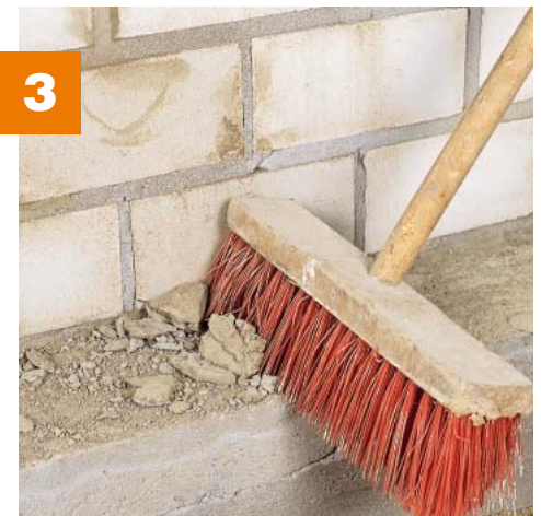
3 Die losen Mörtelreste werden anschließend mit einem Straßenbesen von der Bodenplatte abgefegt.
