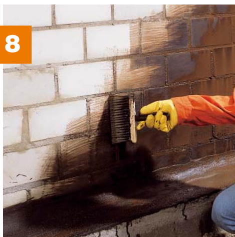
8 Im nächsten Schritt wird die Kelleraußenwand mit einem Voranstrich versehen. Dazu wird der quick-mix Bitumen-Anstrich im Verhältnis 1:10 mit Wasser verdünnt und mit einem Quast vollflächig auf die zu behandelnde Fläche aufgetragen.
