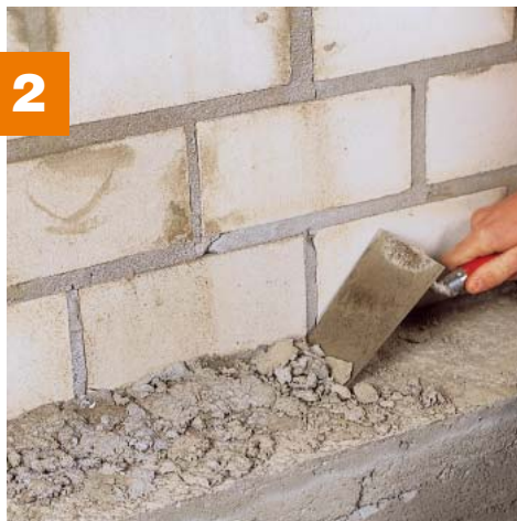
2 Zunächst müssen alte Mörtelreste auf der Bodenplatte entfernt werden.
