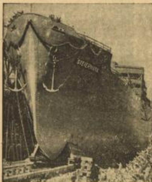
Elektroschiff „Steiermark“ lief vom Stapel. Eine verdiente österreichische Nationalsozialistin taufte in Anwesenheit des stellvertretenden Gauleiters der Steiermark, Dr. Portschy, auf der Kruppischen Germania-Werft in Kiel ein neues diesel-elektrisches Zweischrauben-Frachtschiff auf den Namen „Steiermark“. Unser Bild zeigt das 9000 Tonnen große Schiff, wie es vom Stapel läuft. (Scherl-Bilderdienst-M.)
