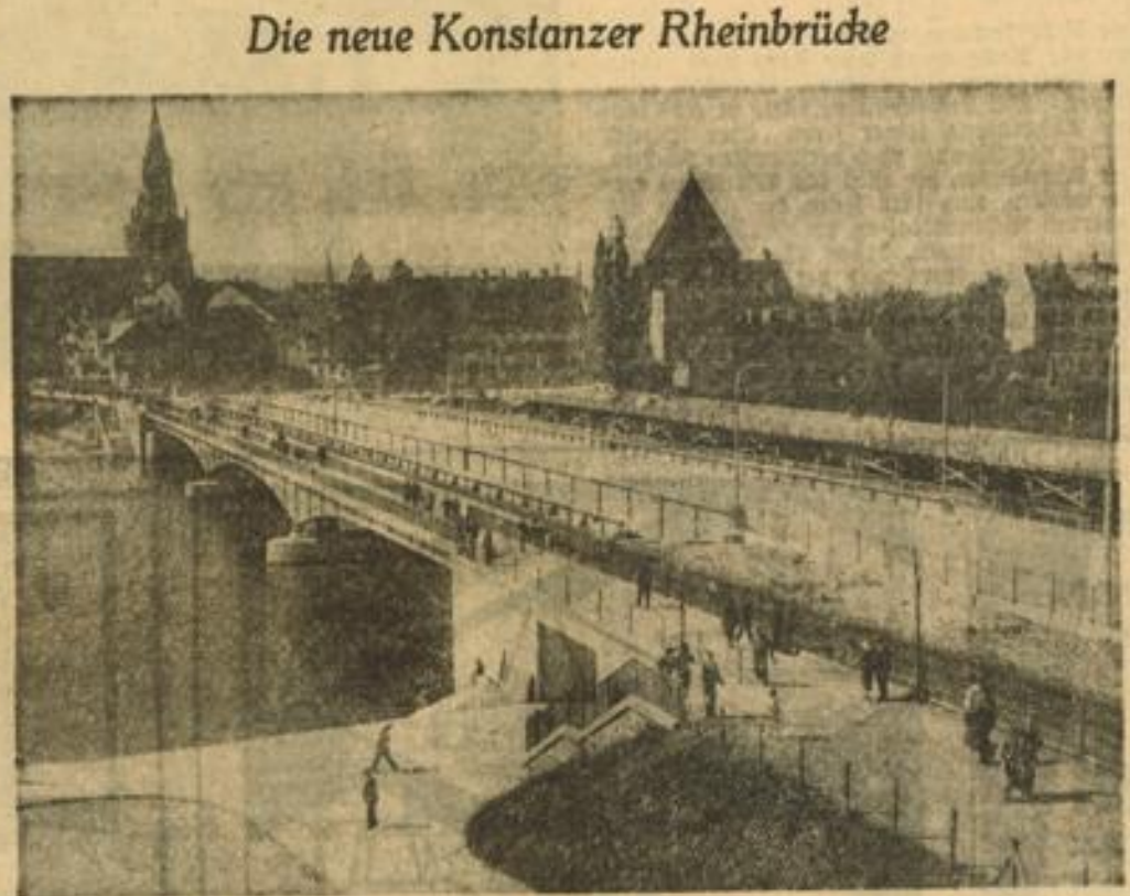
Der Umbau der Konstanzer Rheinbrücke ist nach zweijähriger Bauzeit jetzt so weit fortgeschritten, daß am 25. September die Einweihung dieses gewaltigen Bauwerks stattfinden kann. Damit hat die auf unserem Bild im Hintergrund sichtbare Holzbrücke ihren Dienst erfüllt und wird abgebrochen. Privataufnahme
