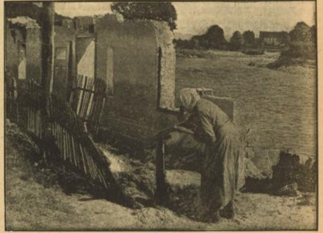
Das folgenschwere Hochwasser in der Grafschaft Glatz. Die Grafschaft Glatz in Schlesien wurde bekanntlich in diesen Tagen von einem schweren Hochwasser heimgesucht, das riesige Zerstörungen anrichtete. Unser Bild gibt einen Begriff von der Größe der Verheerungen, die nach dem Verlaufen des Wassers sichtbar wurden.
