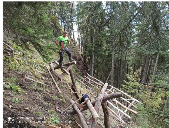
Bild 10: Errichtung von 3-Bein-Böcken
