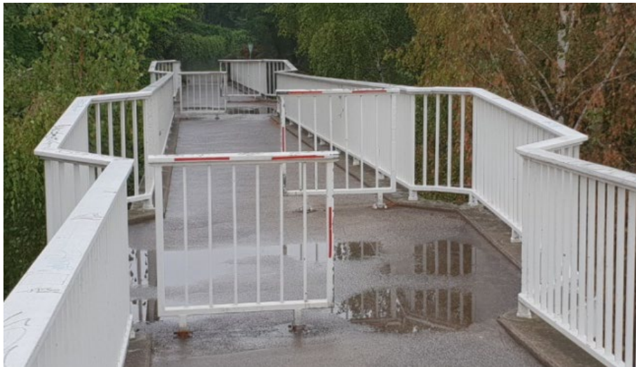
Abbildung 1: Ansicht eines Zwischenpodests im Bestand
