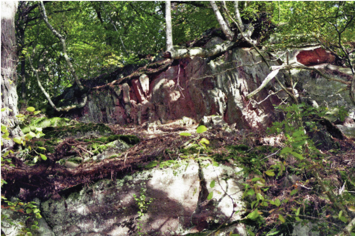
Abb. 19: Tektonische „Zerscheidung“ der Oberen Felszone im Biesterfels südlich von Wallhalben. Diese sehr engständige Klüftung zeigt sich im vorderen oberen Aufschlussbereich.
