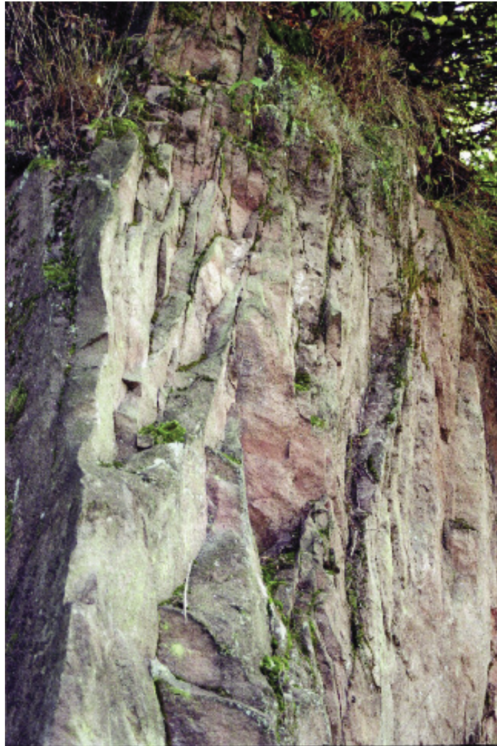
Abb. 14: Tektonisch deformierte Karlstal-Felszone an der Landesstraße L 363 in Horbach. Engständige, Nordost-Südwest-streichende, zum Teil bogig geschwungene Scherklüfte einer (sinistralen) Horizontalverschiebung.
