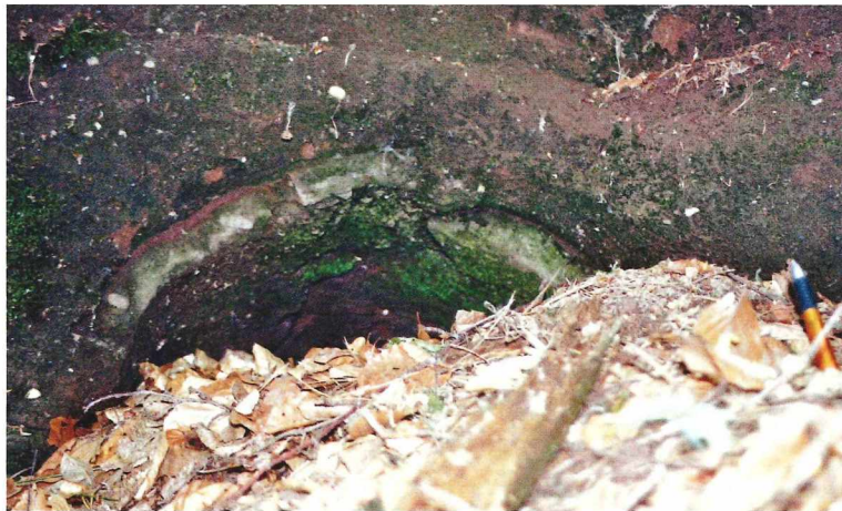
Abb. 19: Etwa 35 cm breite Röhrenstruktur am Wasserwerk Hermersberg. Deutlich erkennbar ist die 3 bis 4 cm dicke Krustenbildung an der Höhlenwand.
